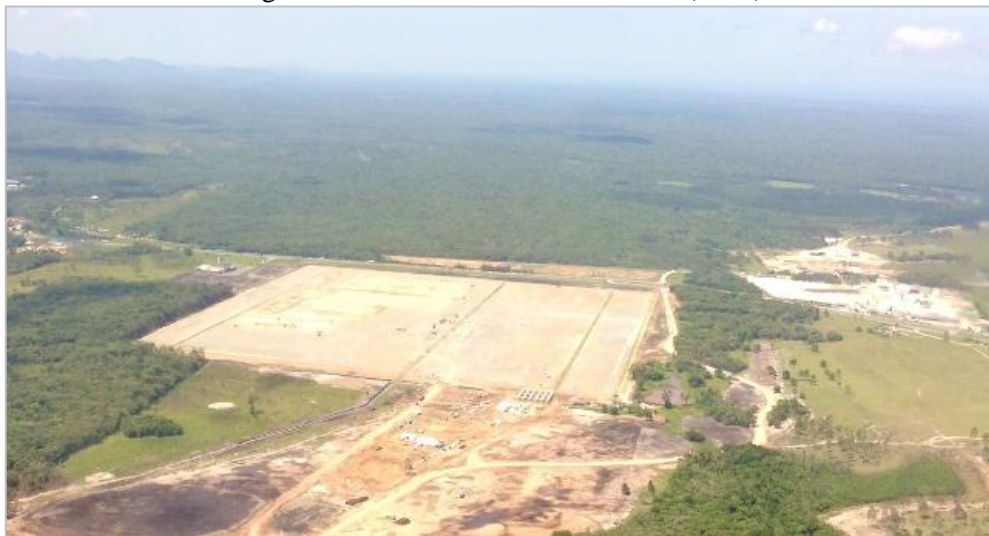
Figura 14. Obras no terreno da BMW (2014)
