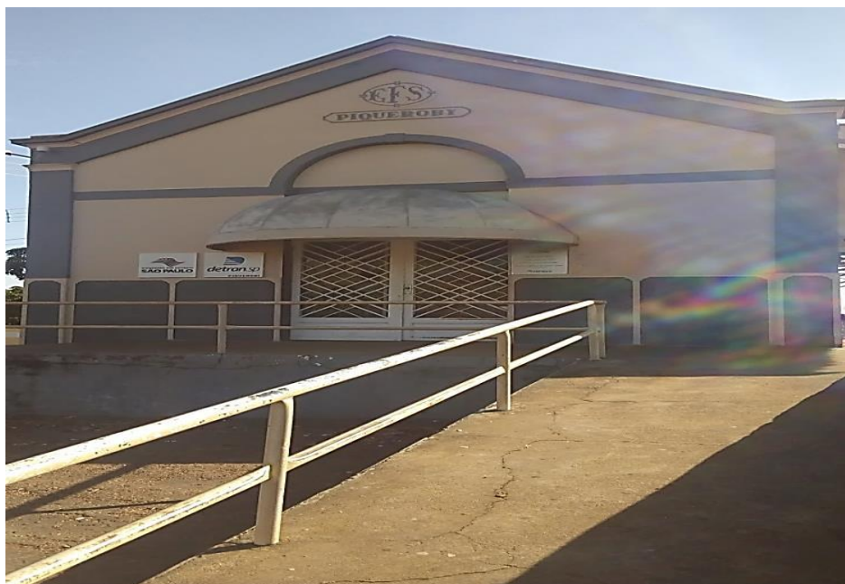
Foto 13. Agência do Detran no prédio da estação ferroviária de Piquerobi/SP.
