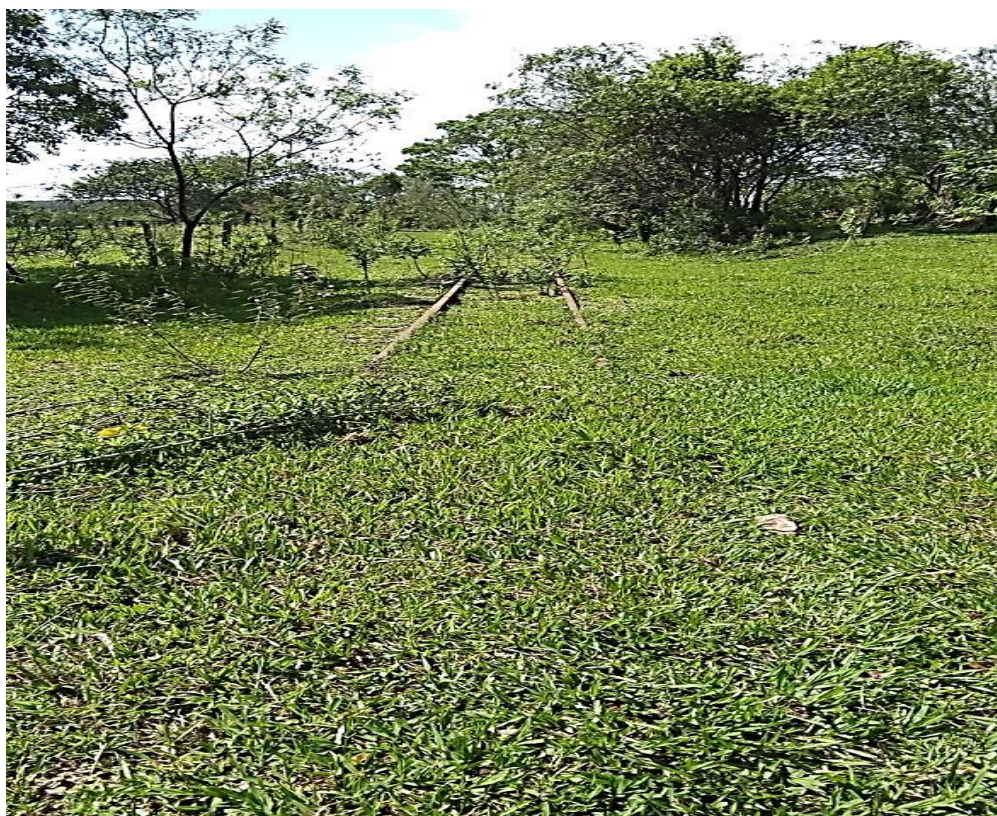
Foto 12. Gramínea cresce junto aos trilhos da ferrovia em Caiuá/SP.
