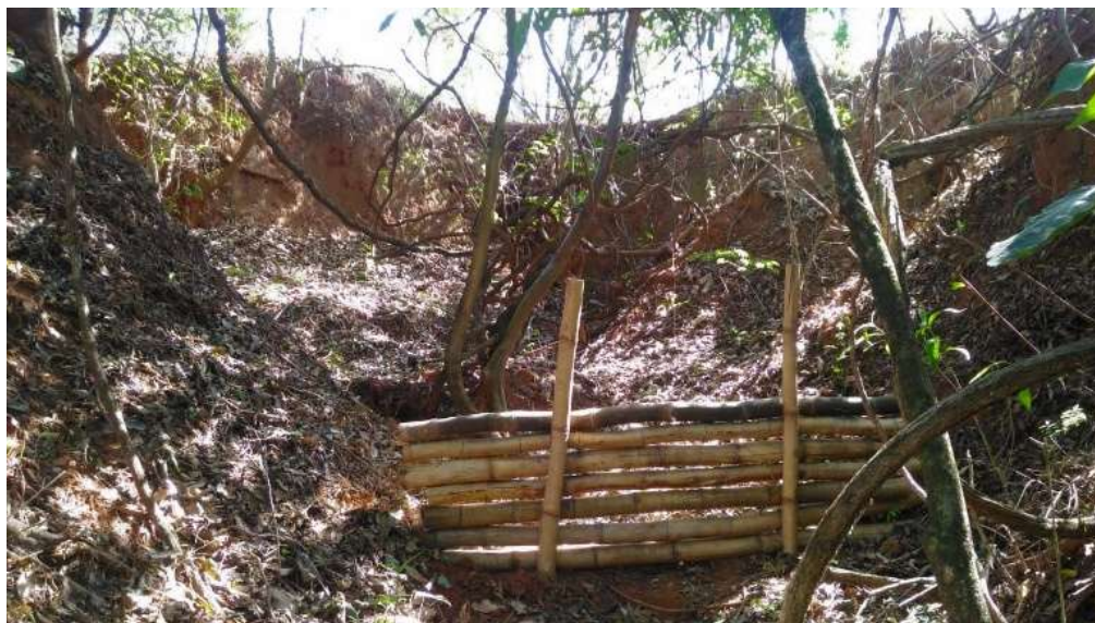
Figura 41- Barramento dentro da voçoroca - 18/08/18.
