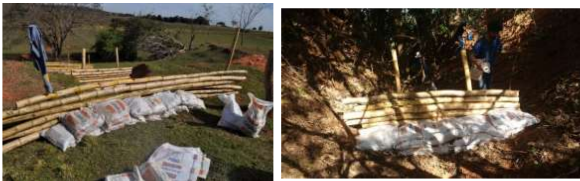
Figuras 05- Barramento de bambus e sacos de r fia prontos.
