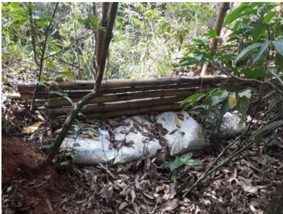
Figura 58 – Barramento 4 dentro da erosão 17/11/18.
