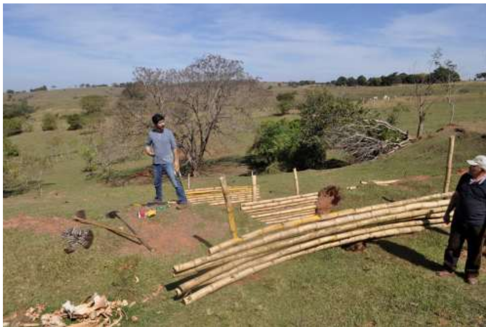
Figura 38 - Primeiros barramentos montados a montante – 11/07/18.
