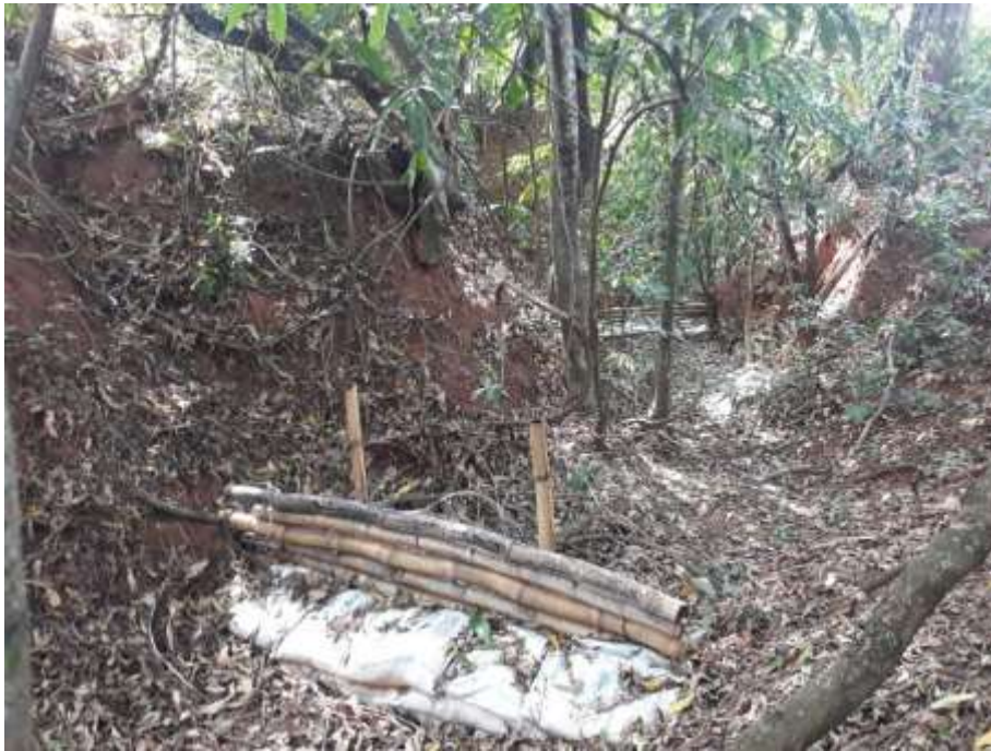
Figura 55 – Barramento 1 dentro da erosão 17/11/18.
