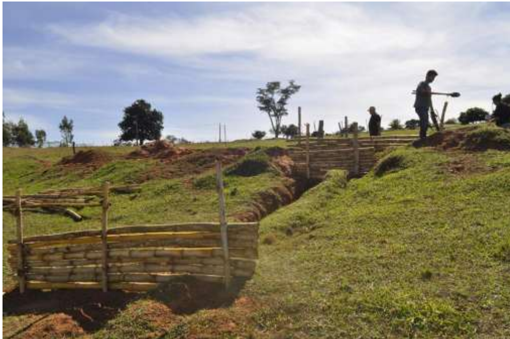
Figura 39 – Barramentos a montante – 11/07/2018.
