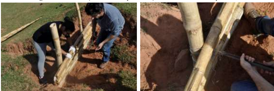
Figuras 03 - Utilização do arame para fixação do bambu no seu apoio vertical.
