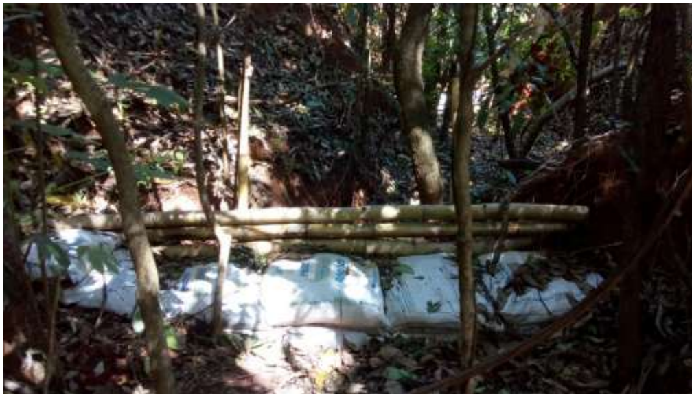
Figura 56 – Barramento 2 dentro da erosão 17/11/18.
