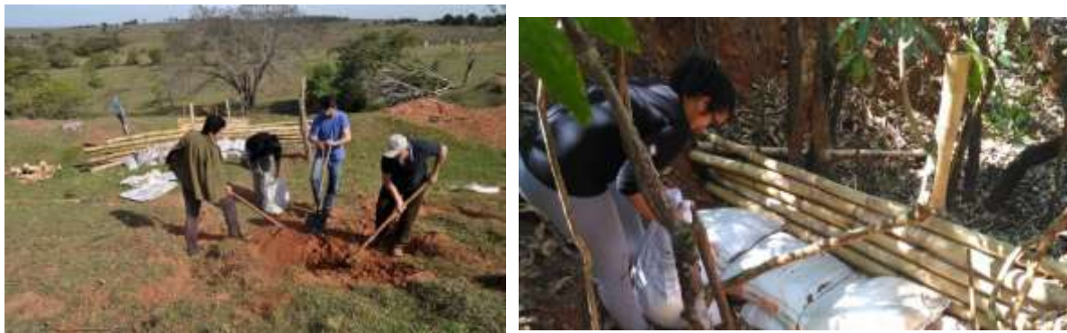
Figuras 04 - Preenchimento dos sacos de rafia e posterior encaixe nas paliçadas.
