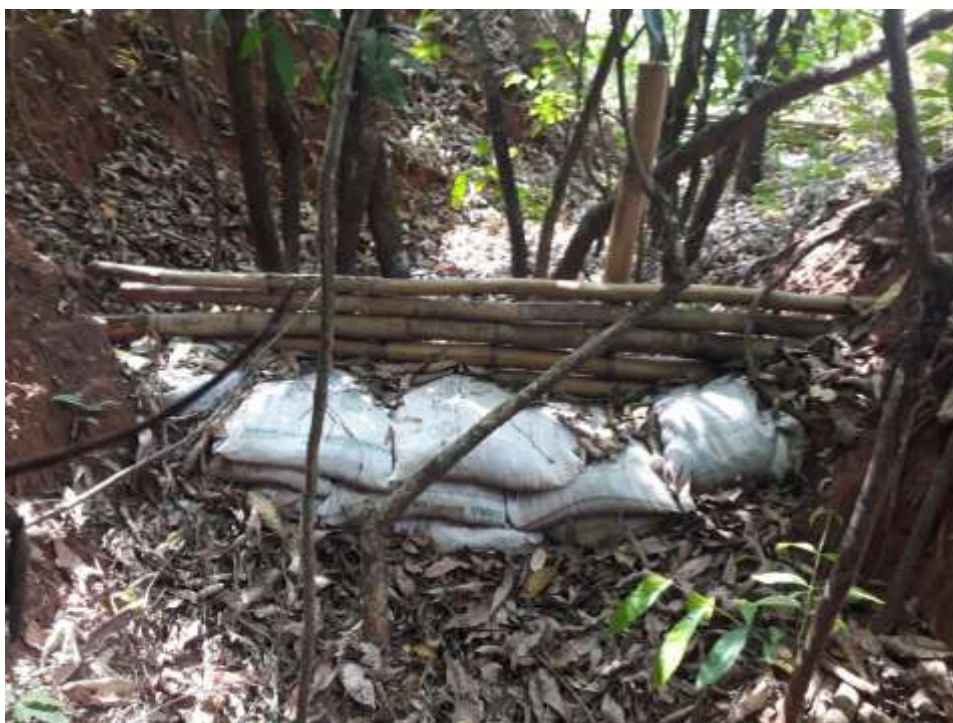
Figura 57 – Barramento 3 dentro da erosão 17/11/18.
