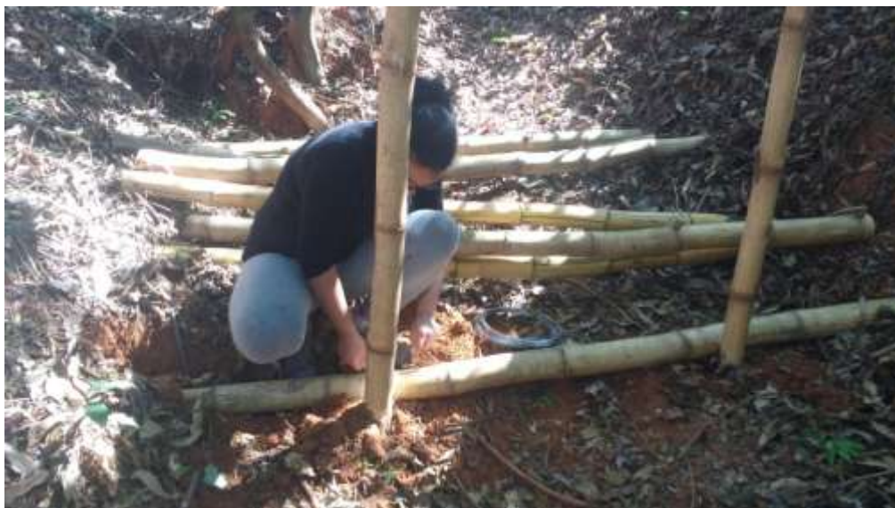
Figuras 40 – Montagem dos barramentos dentro da voçoroca – 18/08/18.
