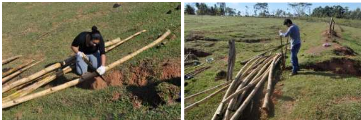
Figuras 02 – Primeiros passos para a montagem dos barramentos.
