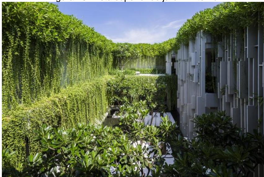
Figura 10: Vista superior do jardim interno.
