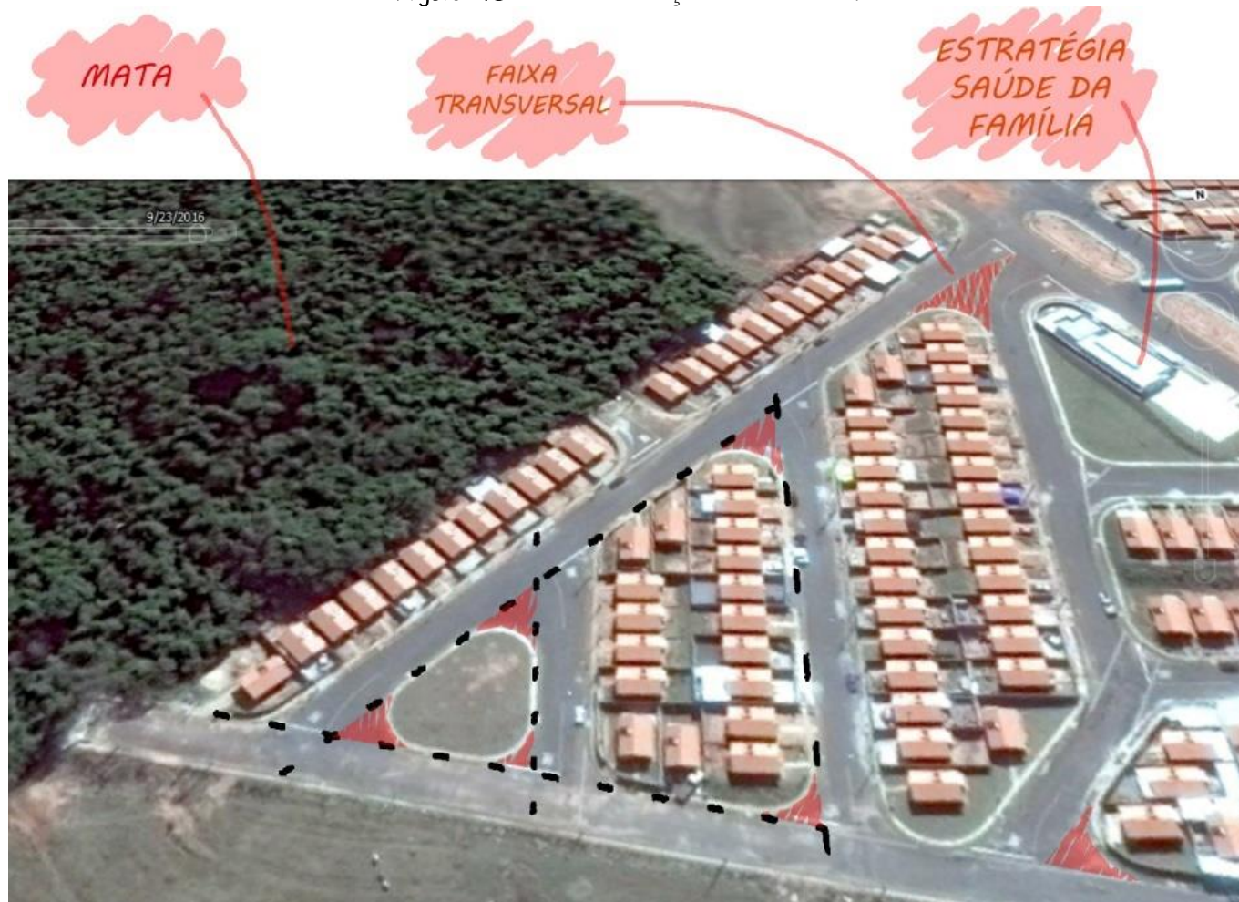
Figura 43: Vista da Praça 7 do CHJDN.
