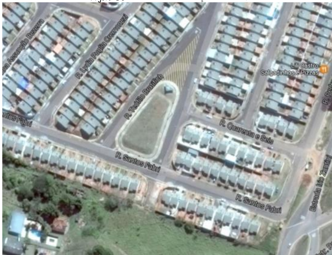
Figura 39: Vista aérea da Praça 4 CHJDN.
