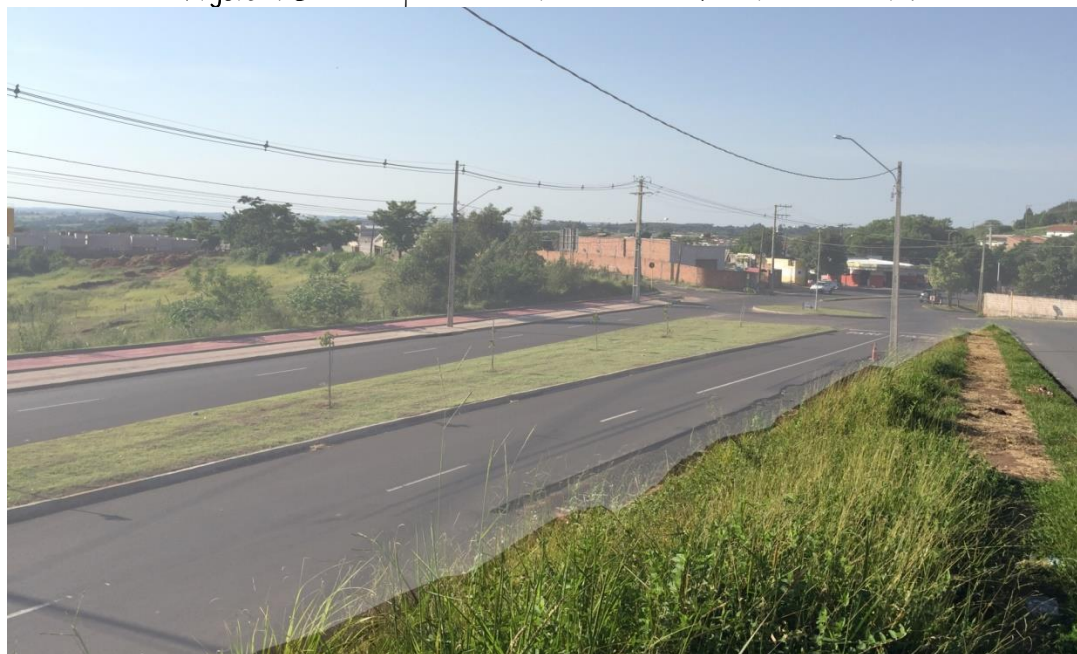
Figura 16: Vista parcial da via Estrada Raimundo Maiolini.
