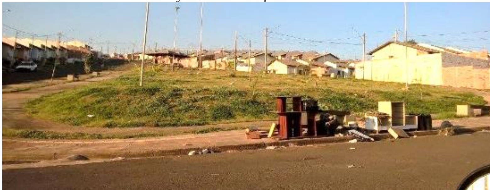
Figura 40: Vista da Praça 4 do CHJDN.
