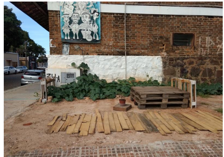
Figuras 51-54– Intervenção realizada Fonte: Acervo autor. 2018
