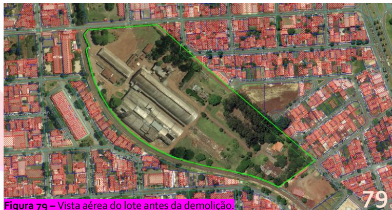
Figura 79 – Vista aérea do lote antes da demolição. Fonte: Prefeitura de Ourinhos, 2017.
