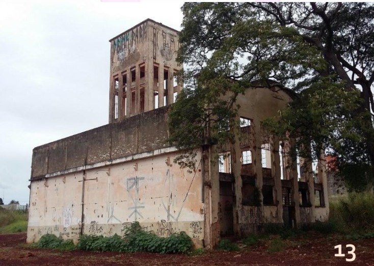
Figuras 13 - Antigo Refeitório da SANBRA. Fonte: BACCILI PEREIRA, V., 2017. Figuras 14 - Silo da NEVA. Fonte: BACCILI PEREIRA, V., 2017.
