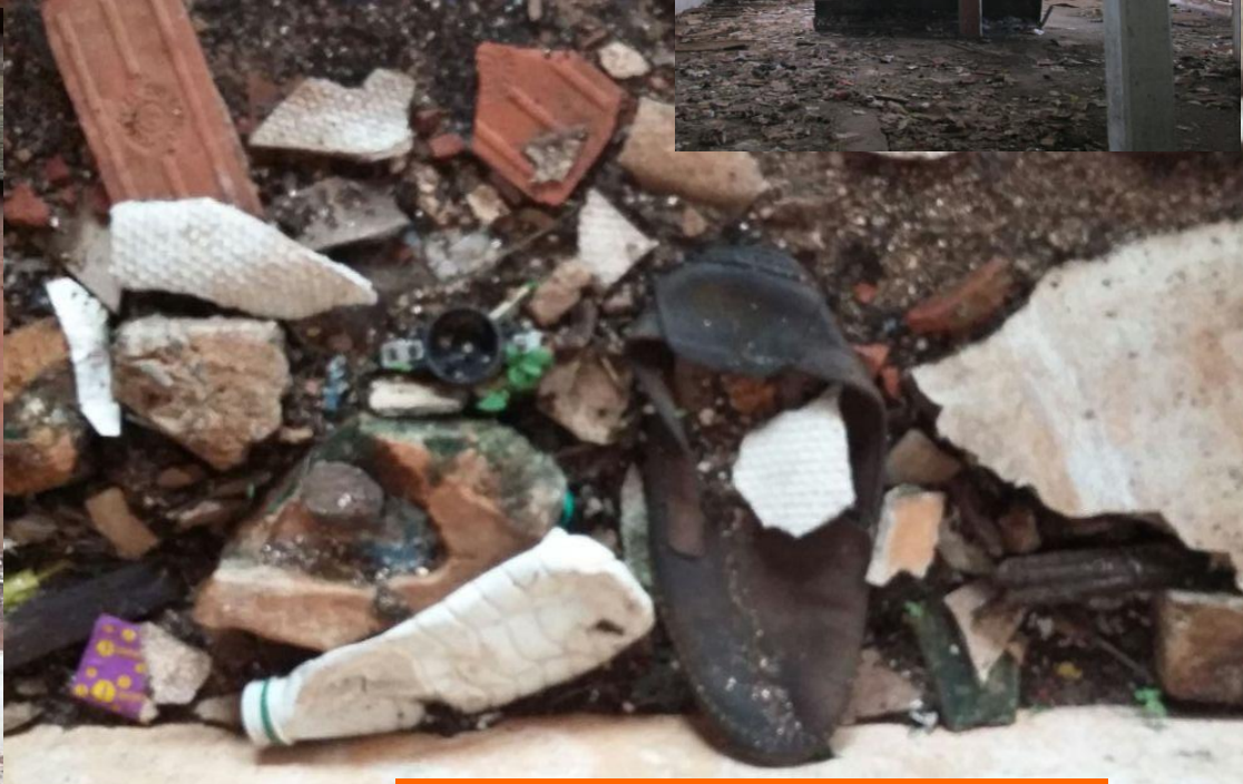
Figura 20 – Fotos do Interior do Refeitório da SANBRA e do silo. Fonte: BACCILI PEREIRA, V., 2017.
