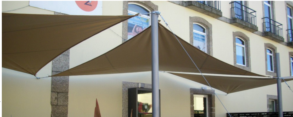
Figura 17 ▶ Exemplo de estrutura de vela tensionada. Fonte: Tolniber (2018)
