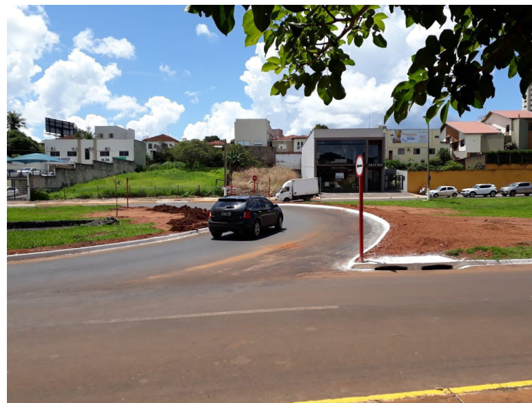
Figura 30 – Nova via criada em cima da área tamponada. Fonte: autoral.
