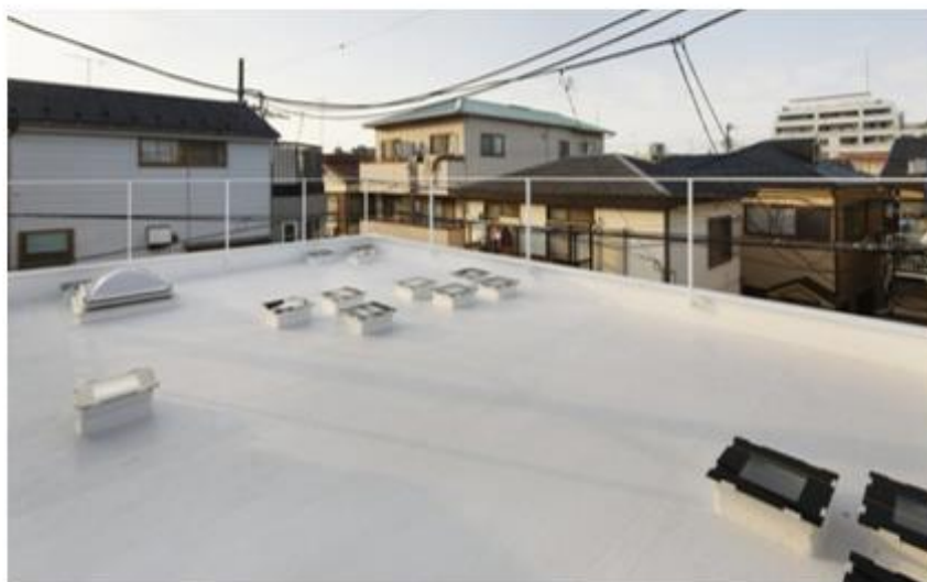
Figura 16: Cobertura com aberturas para comunicação com interior do anexo
