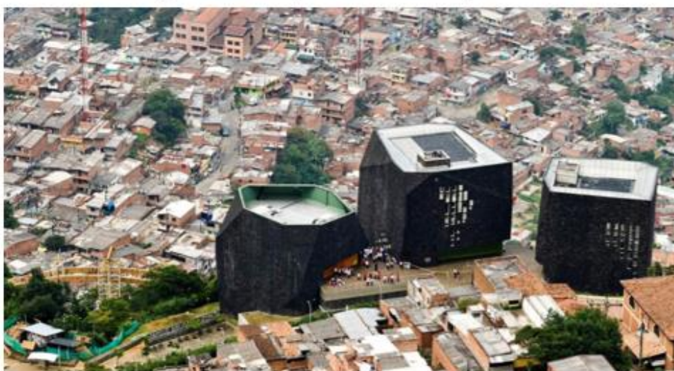
Figura 28: Parque Biblioteca Espanha
