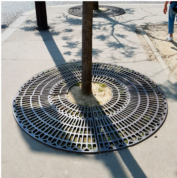
Figura 51 - Grade para árvore com passagem superior em Paris. Rodrigo Guerra, 2016.
