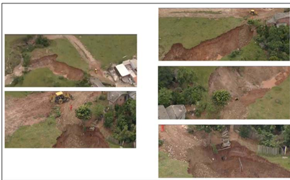
Figura 27 – Fotos mostrando erosão de grande magnitude em São José dos Campos, SP. Fonte: G1, 2017
