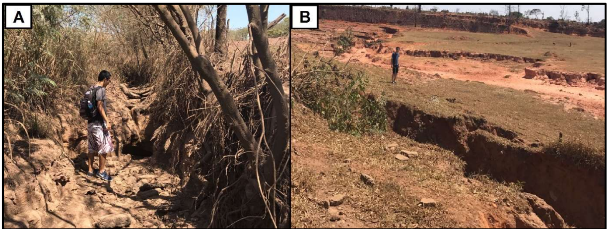
Figura 56 - Em “A”, processo erosivo linear produzindo ravinas de proporções métricas ao lado da estrada de terra. Em “B”, ravinas possuindo profundidades superiores a 4 metros e comprimento chegando até centenas de metros.
