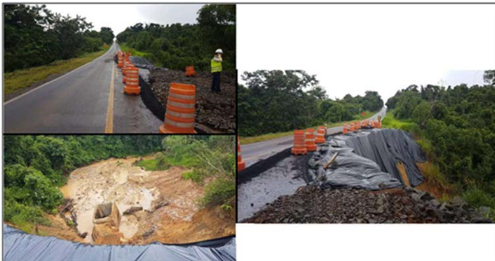
Figura 33 – Fotos mostrando erosão na lateral da rodovia. Fonte: G1, 2018.
