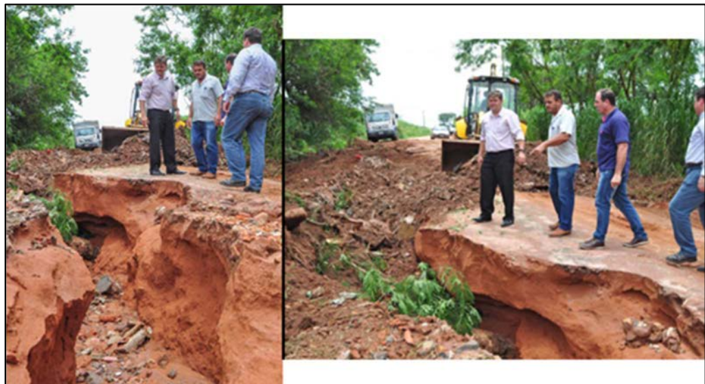
Figura 25 – Fotos apresentando erosão em estrada rural no Município de Rio Claro, SP. Fonte: Imprensa da Prefeitura de Rio Claro, 2017.
