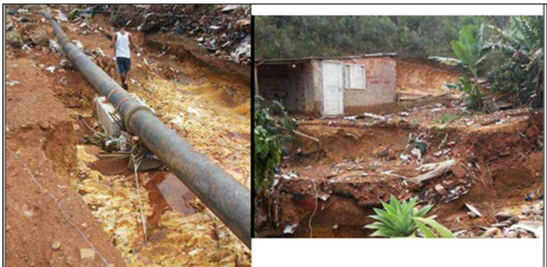
Figura 14 – Erosão expõe tubulação e colocando moradia em risco. Fonte: Correio Braziliense, 2015.
