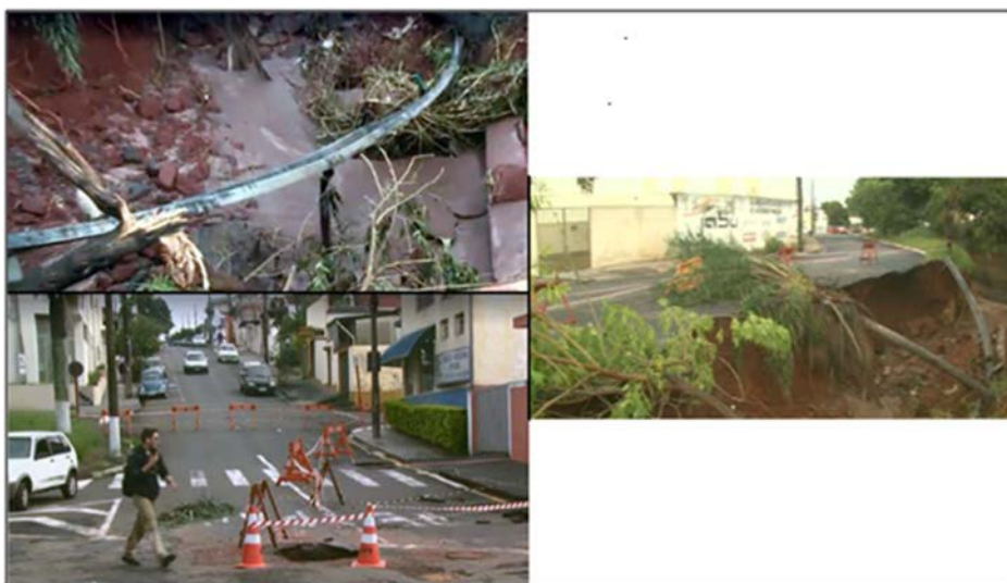
Figura 39 – Erosão afetando via marginal de córrego em São Carlos, SP. Fonte: G1, 2018.
