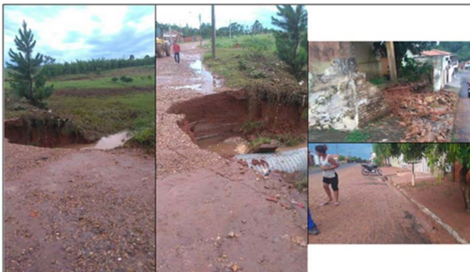
Figura 37 – Erosão com danos em vias e edificação em Botucatu, SP. Fonte: Agência14news, 2018.
