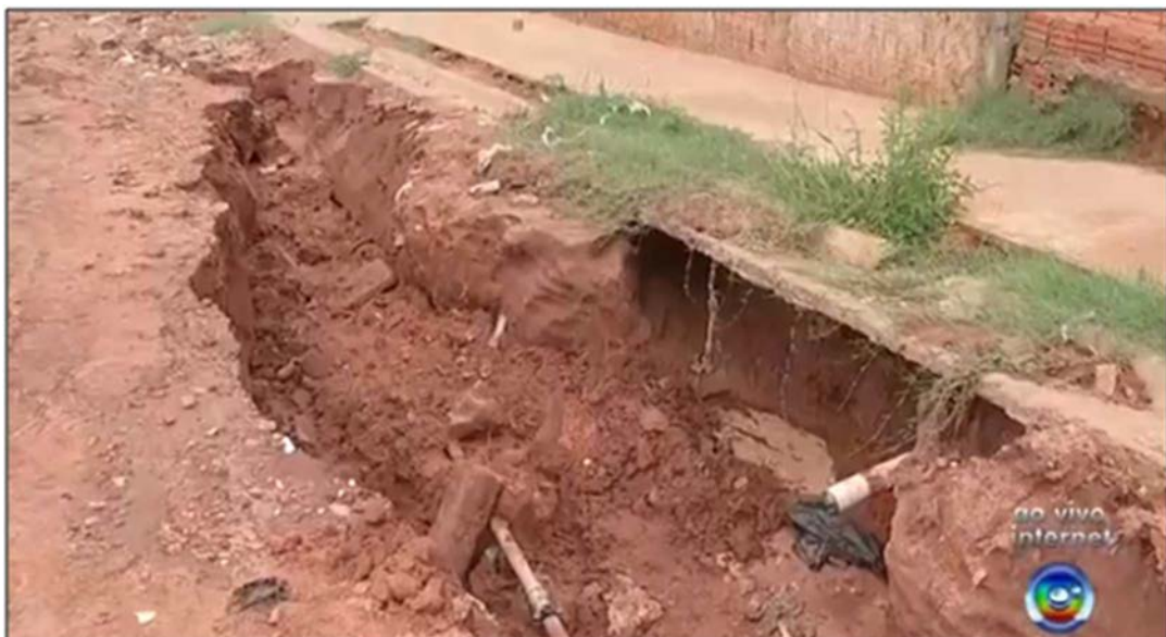
Figura 23 – Foto apresentando erosão expondo encanamentos enterrados, em via pública, em Bauru (SP). Fonte: G1, 2016.
