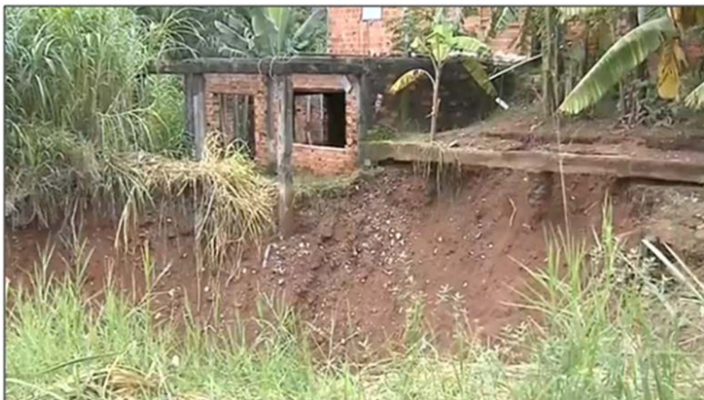
Figura 18 – Erosão atingindo edificações na cidade de Marília, SP. Fonte: G1, 2016.
