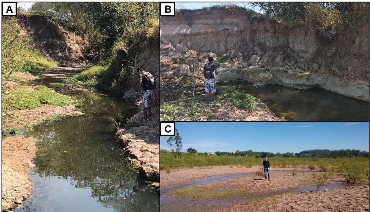
Figura 58 - Em “A”: ravinas e feições erosivas ao longo do Córrego Jacutinga espacialmente atrelado ao perímetro urbano. Em “B”: assoreamento denotado pela posterior erosão ao longo do trajeto do canal do Córrego Jacutinga. Em “C”: depósito de assoreamento em um patamar ao longo do canal do Córrego Sobrado.
