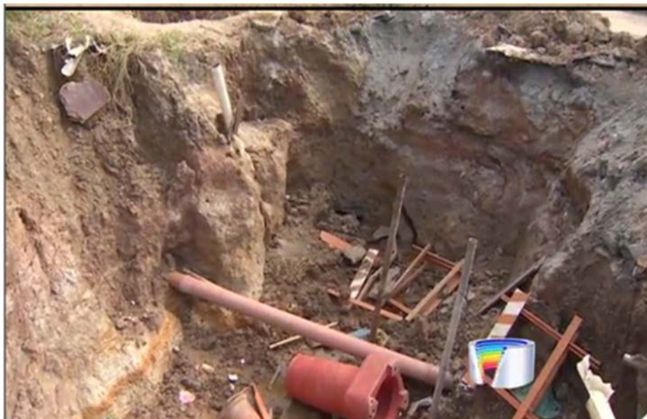
Figura 12 – Erosão expondo encanamentos enterrados no local. Fonte: G1, 2015.
