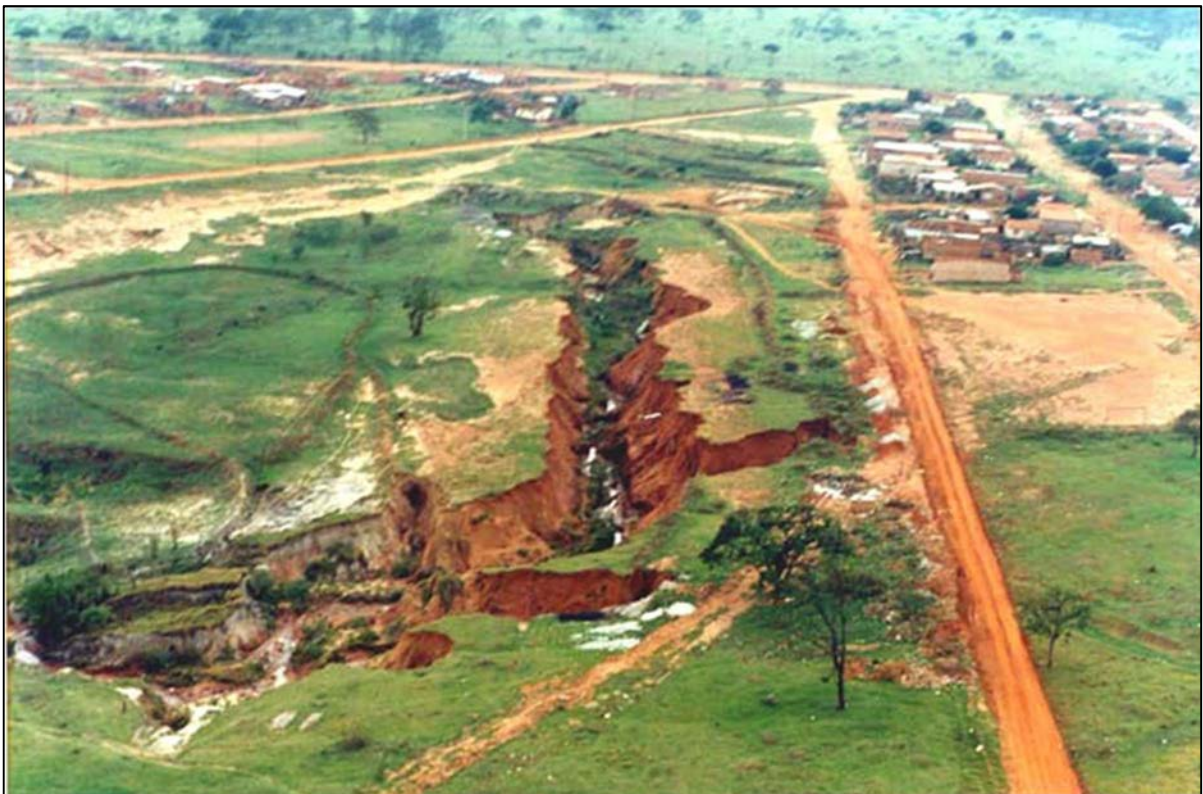
Figura 48 - Vista geral da erosão do Parque Bauru, em 1993. Fonte: IPT.
