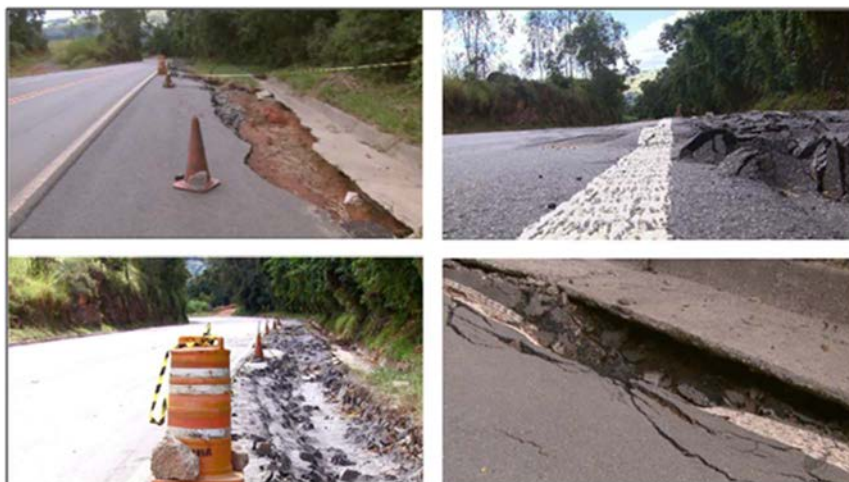
Figura 31 – Fotos mostrando erosão na lateral da rodovia. Fonte: G1, 2017.
