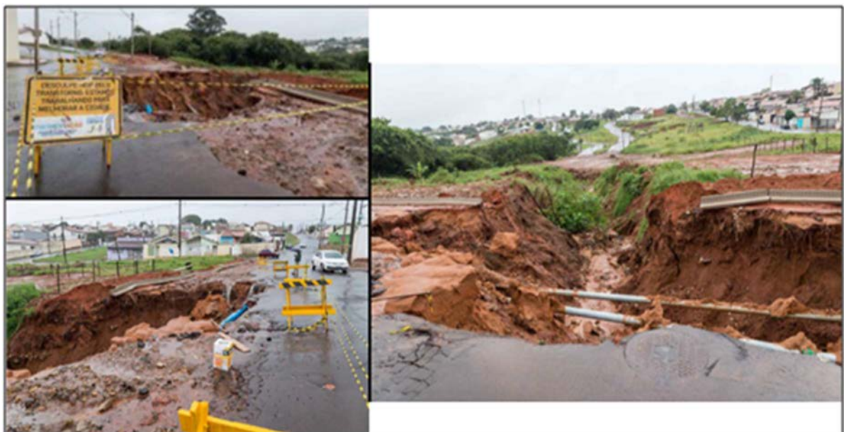
Figura 20 – Fotos mostrando danos causados pela erosão na cidade de Botucatu, SP. Fonte: Jornal Acontece Botucatu, 2016.
