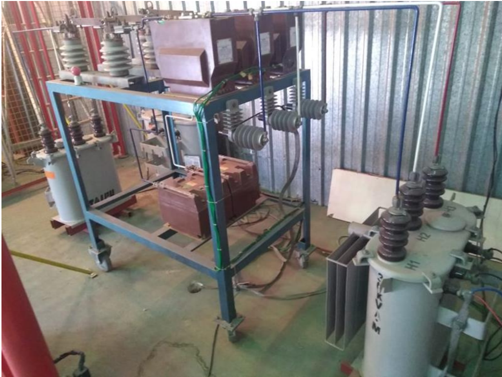
Figura 15 – Subestação 220V/13.800V/220V
