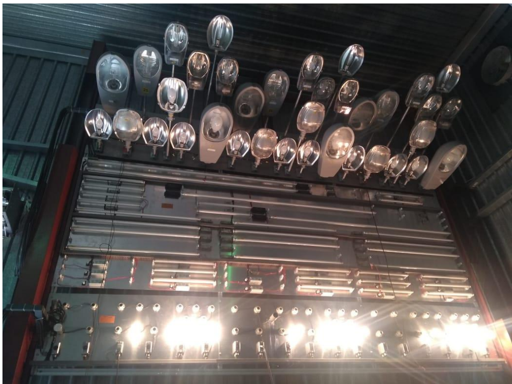
Figura 16 – Banco de cargas de iluminação
