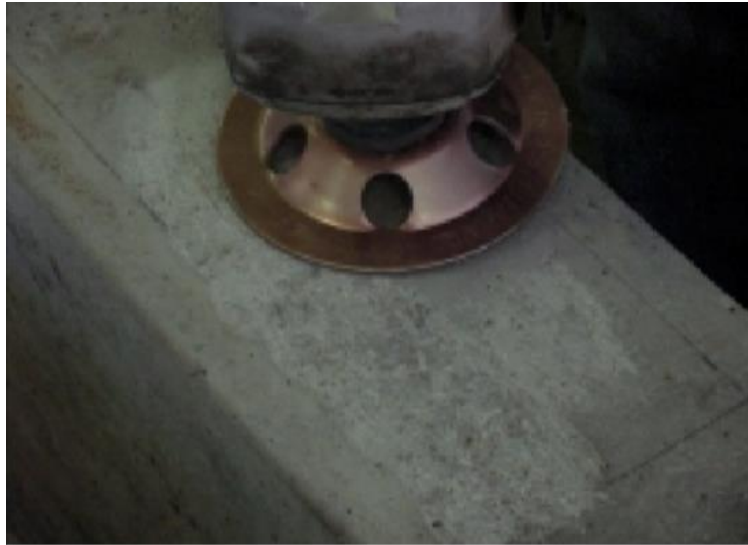
Figura 16: Esmerilagem da superfície de concreto.
