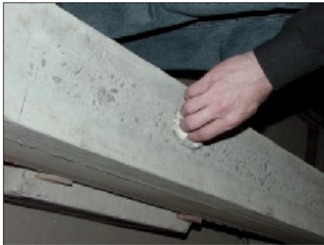
Figura 17: Superfície de concreto preparada para a aplicação do reforço.
