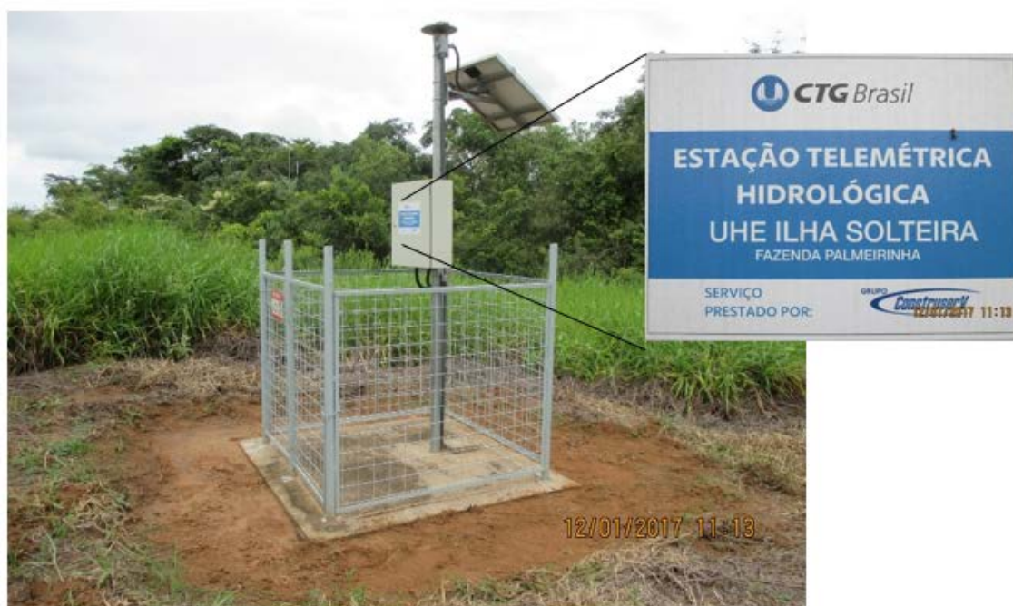
Figura 14 – Estação Telemétrica – Fazenda Palmeirinha
