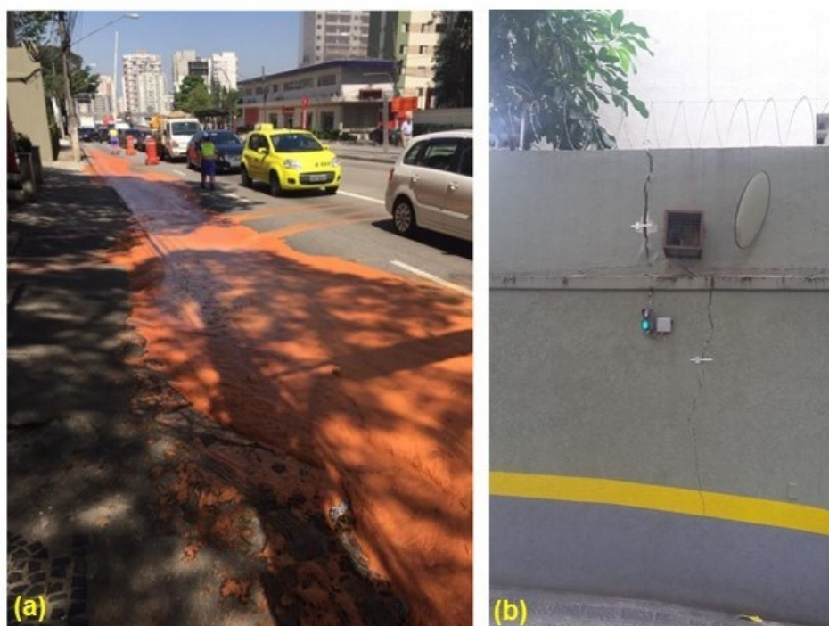
Figura 44. Ocorrências em superfície (Av. Santo Amaro): (a) vazamento de espuma/solo na altura do anel 2340; e (b) deformação em superfície provocando rachaduras em muro de alvenaria (anel 2348).
