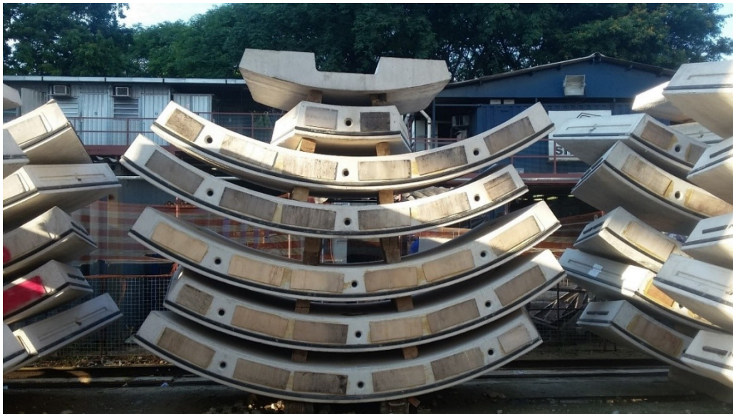
Figura 24. Vista lateral dos segmentos no pátio de anéis do VCA Conde de Itú.
