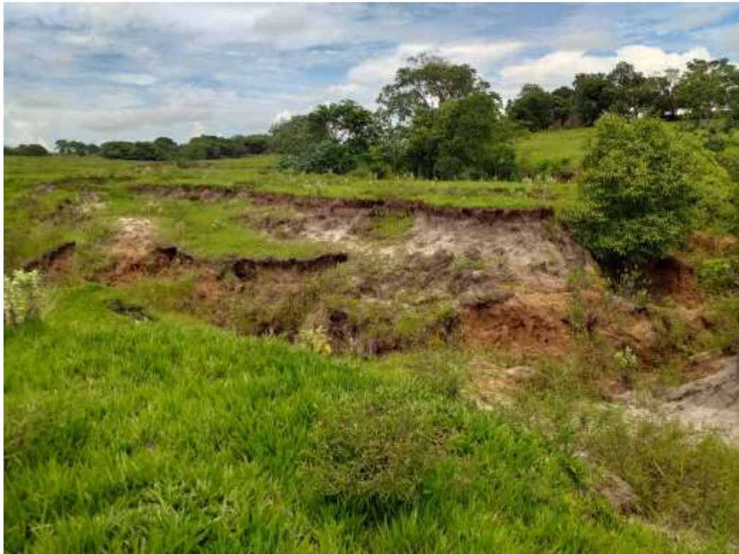
Figura 10 – Voçoroca existente na Microbacia Hidrográfica do Córrego do Boi
