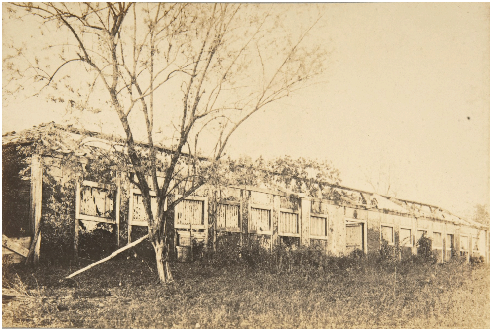
Figura 12a – No alto, almoxarifado, detalhe da Planta da Colônia Militar de Itapura , 1885. Fonte: Acervo da Fundação Biblioteca Nacional do Rio de Janeiro. Figura 12b – Acima, fotografia do almoxarifado, c. 1905. Fonte: Exploração do Rio Tieté . Álbum de fotografias. Acervo do Centro Museu Geológico do Instituto Geológico de São Paulo.
