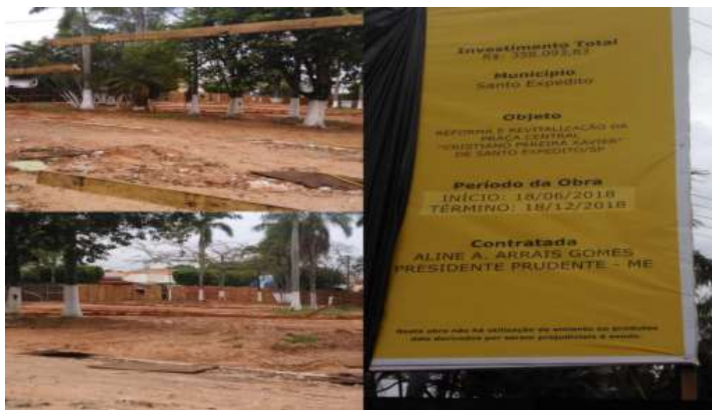
Figura 11 - Obra inicial de revitalização da Praça Central de Santo Expedito (2018).
