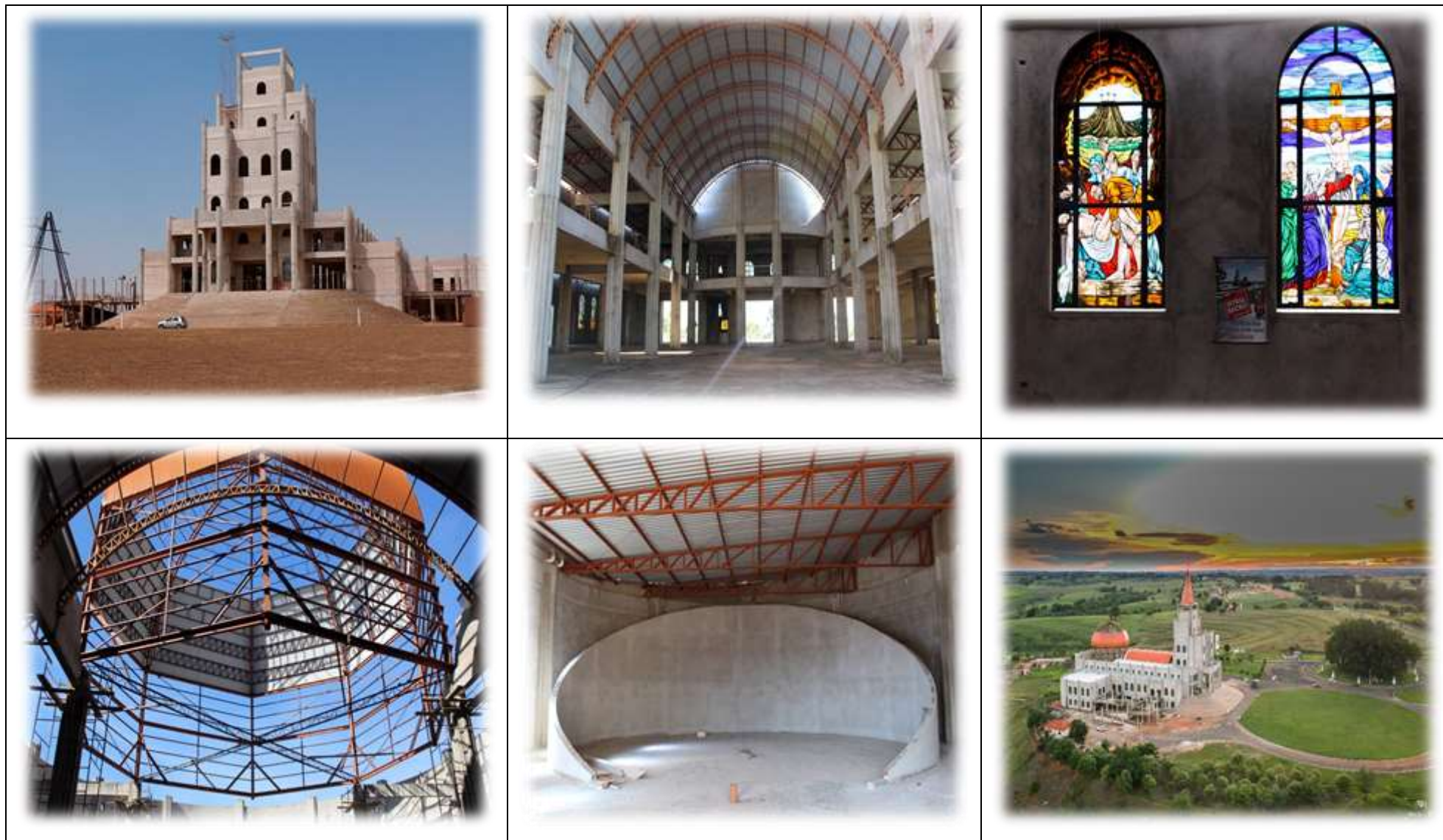
Quadro 9 - Santuário de Santo Expedito em construção etapas concluídas até 2021.
