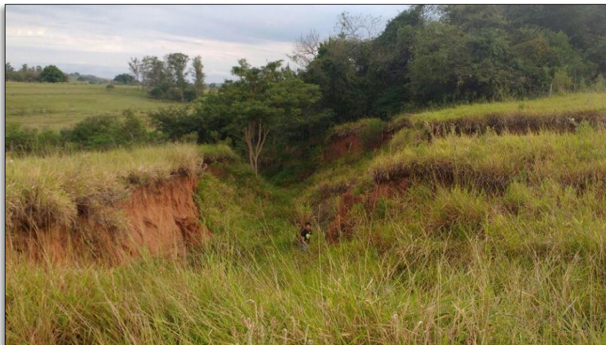
Figura 14: Erosão 1 em fase estável.
