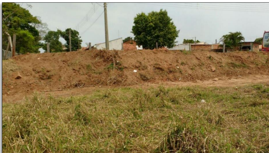
Figura 20: Intervenção da prefeitura contra o escoamento superficial na área de pastagem próxima a Erosão 2.
