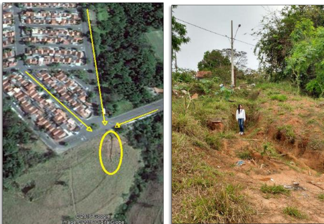
Figuras 18 e 19: Erosão 2.
