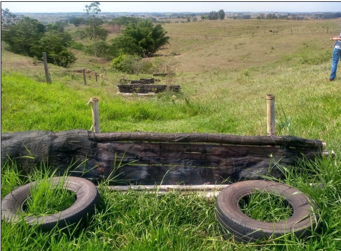
Figura 9-Técnica de paliçada de bambu feita em um trecho da área de estudo.
