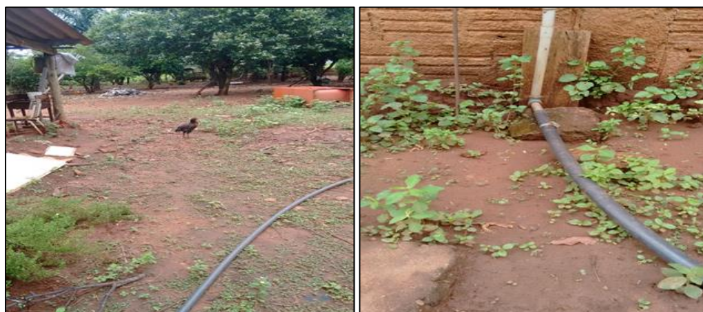
Figura 9 - Tubulação superficial em lote do Assentamento Estrela da Ilha. (A) Presença de animal próximo a tubulação (B) Tubulação que faz ligação entre poço à residência exposta ao solo.
