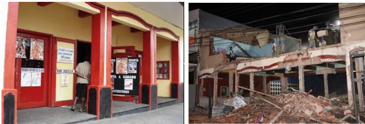
Figura 22 e 23 – Cine Vila Rica e sua demolição
