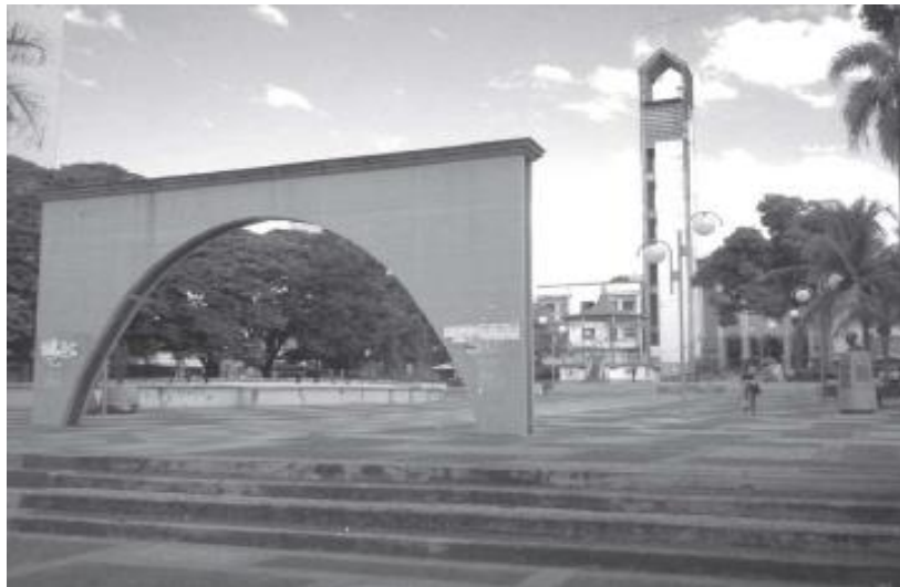
Figura 14 – Praça Rui Barbosa após a reforma
