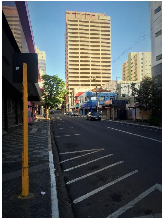
Figura 31 – Edifício garagem presente na região central de Bauru
