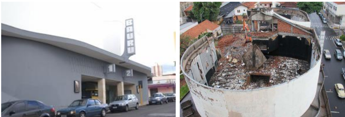
Figura 20 e 21 – Cine Bauru e sua demolição
