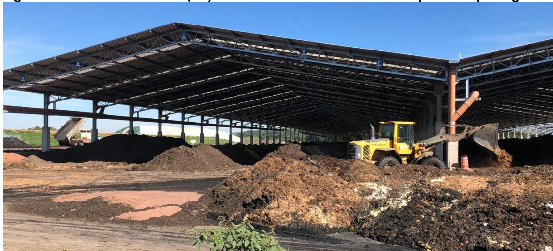
Figura 39 - Leiras em Jundiaí (SP) onde é destinado o lodo da ETE para compostagem.
