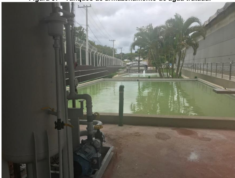
Figura 37 - Tanques de armazenamento de água tratada.
