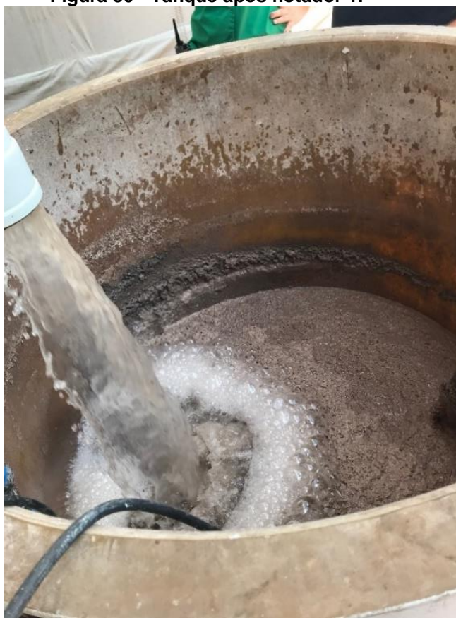
Figura 30 - Tanque após flotador 1.
