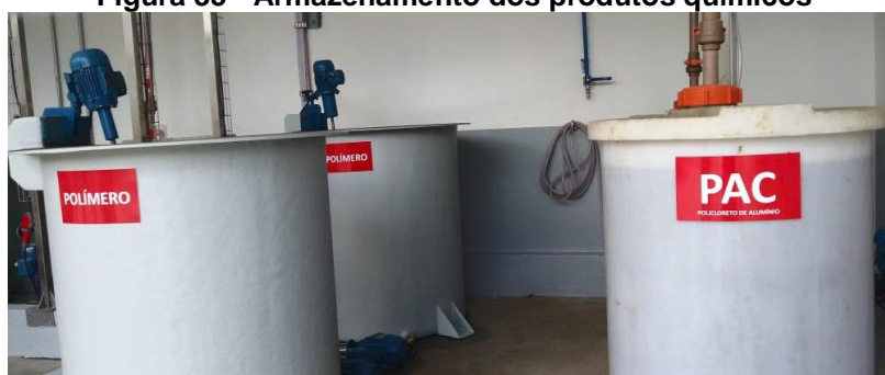
Figura 35 - Armazenamento dos produtos químicos
