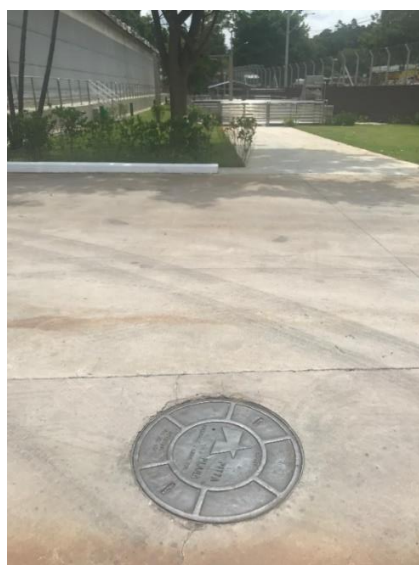
Figura 21 - Poço de Visita (PV)
