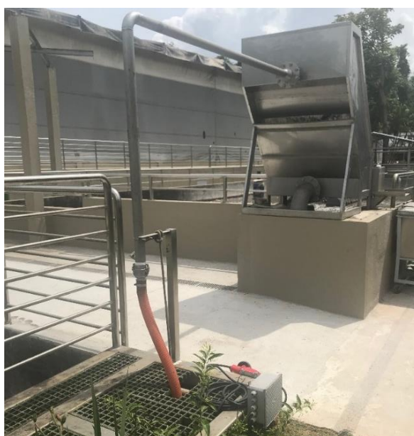
Figura 24 - Bombeamento do efluente da caixa de gordura para a peneira estática.
