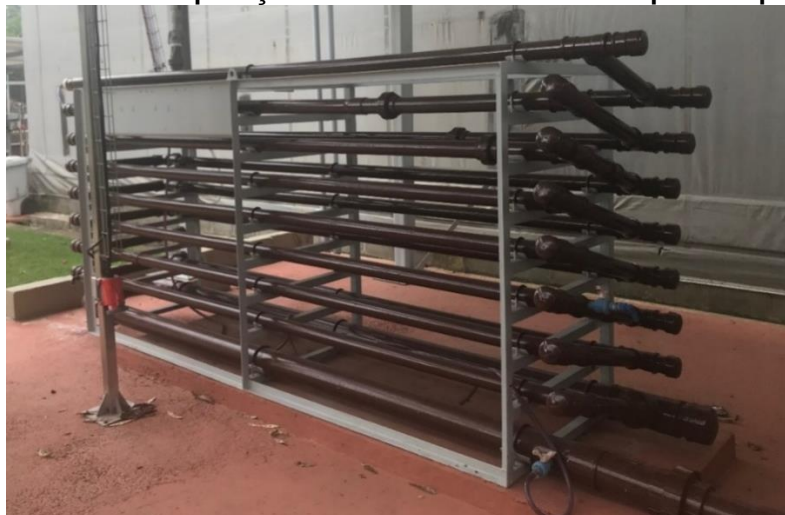
Figura 28 – Local de aplicação do PAC no efluente do tanque de equalização
