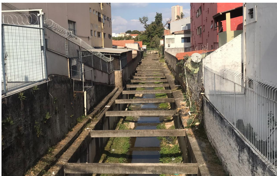
Figura 4 - Edificações negando o curso d'água em meio urbano no município de Sorocaba (SP)
