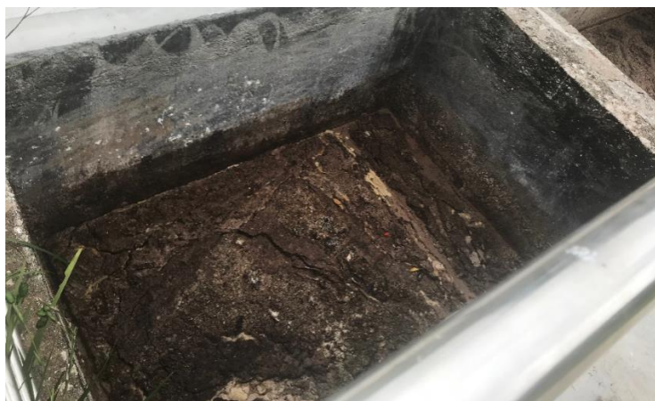
Figura 23 - Interior da Caixa de Gordura da ETE.
