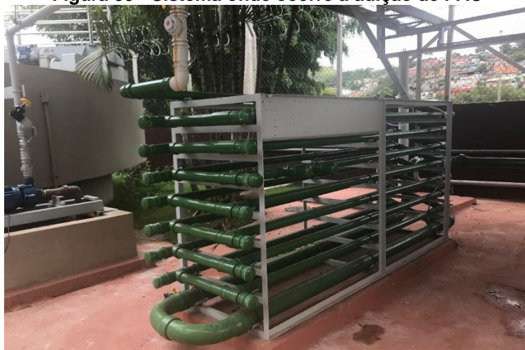
Figura 33 - Sistema onde ocorre a adição de PAC
