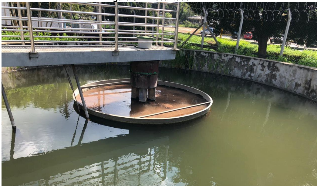
Figura 32 - Decantador
