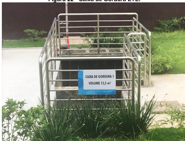
Figura 22 - Caixa de Gordura ETE.
