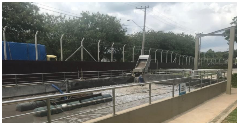
Figura 27 - Visão geral do tanque de equalização: misturador, aerador e peneira estática.
