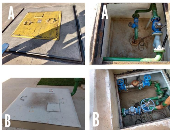
Figura 20 - Poços artesianos de abastecimento da indústria. A: Poço 01 / B: Poço 02.
