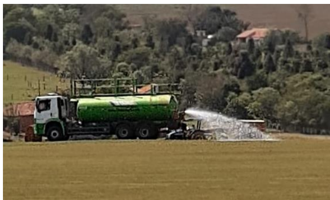
Figura 6 - Lâmina de água sendo aplicada por meio de caminhão pipa
