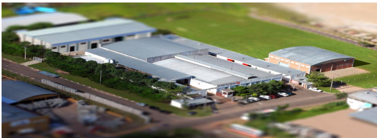
Figura 5 - Instalações da empresa Stetsom
