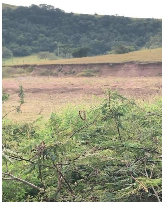
Figura 15 - Monitoramento de processos erosivos na margem do reservatório.
