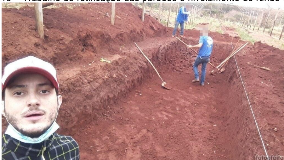
Figura 19 – Trabalho de retificação das paredes e nivelamento do fundo da BET.
