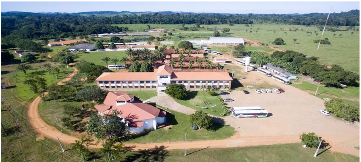
Figura 6 - Prédios do Campus Ariquemes.
