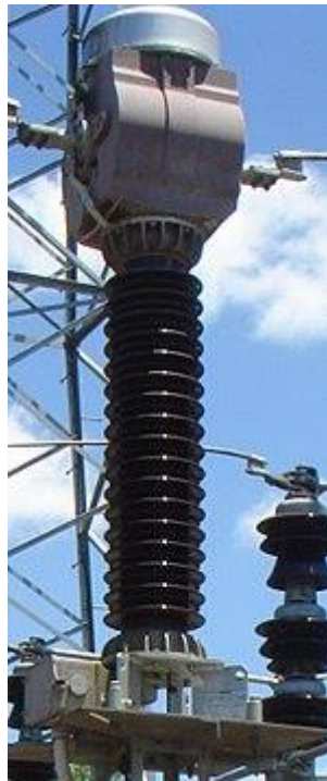
Figura 17. Transformador de 138kV em operação.
