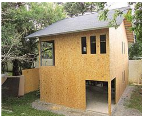
Figura 4 – Sistema Construtivo Wood Frame
