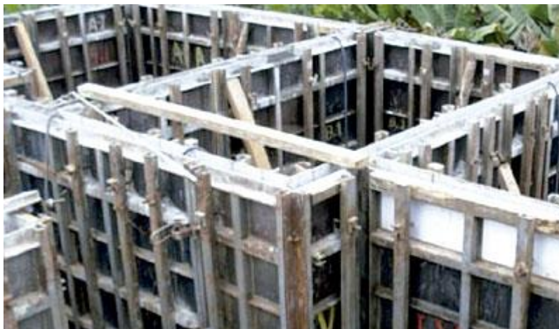
Figura 5 – Parede de Concreto Moldado In Loco
