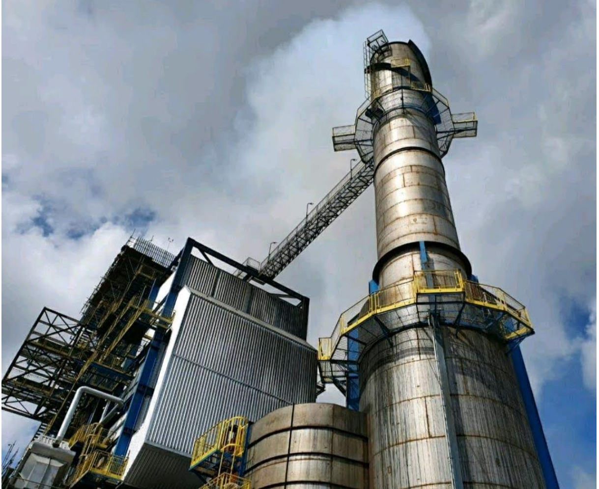
Figura 12 – Caldeira de geração de vapor
