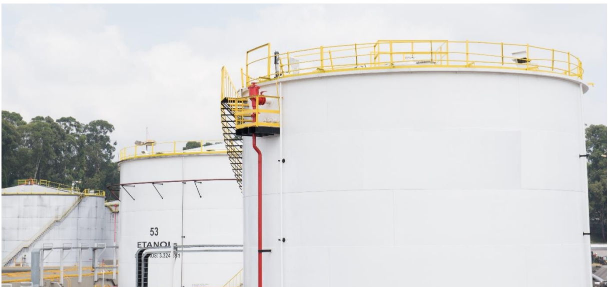
Figura 11 - Tanques de etanol
