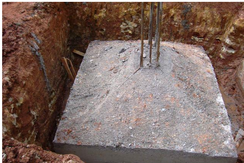
Figura 01 – Exemplo de fundação rasa.
