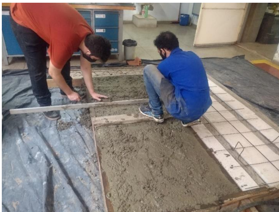
Figura 53 – Nivelamento da massa de concreto da laje
