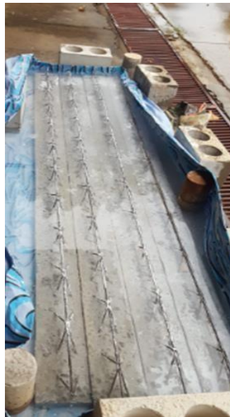
Figura 49 – Cura das treliças realizada por imersão em água
