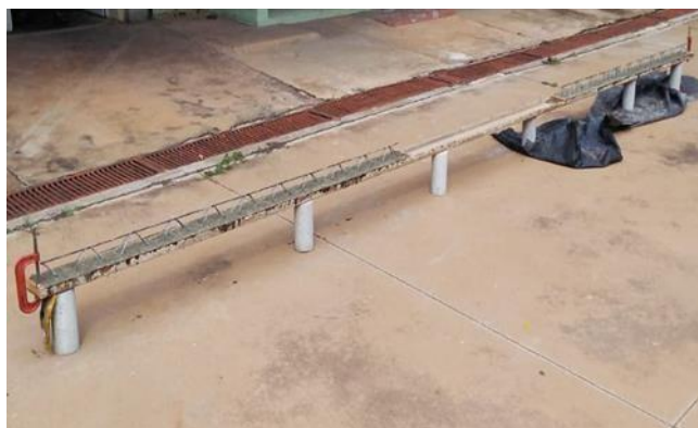
Figura 47 – Fôrma Metálica Utilizada na Concretagem das Vigotas
