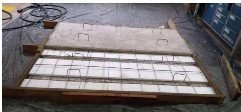
Figura 60 – Laje pronta para ser concretada e laje já concretada
