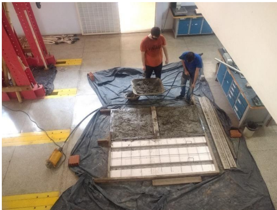
Figura 52 – Despejo e Adensamento do Concreto
