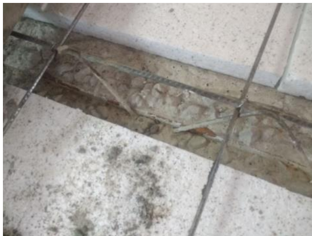
Figura 48 – Vigota treliçada com adição de bambu e já posicionada na Laje a ser concretada
