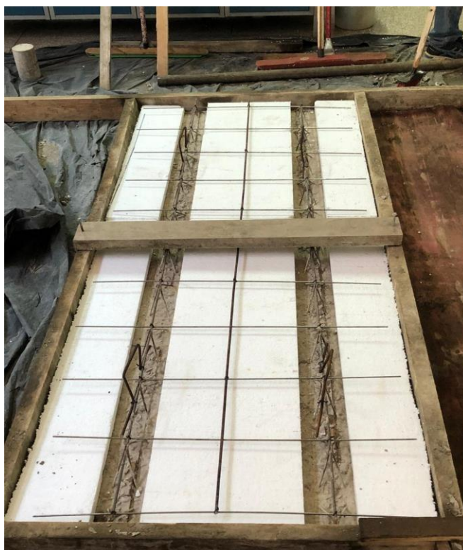
Figura 51 – Laje armada e pronta para ser concretada
