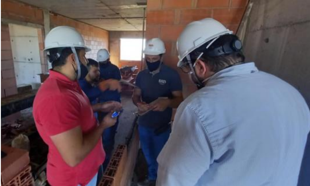
Figura 19 – Acompanhamento de Atividades em Obra
