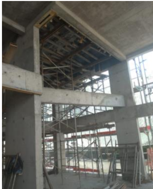
Figura 5 – Reescoramento em obra
