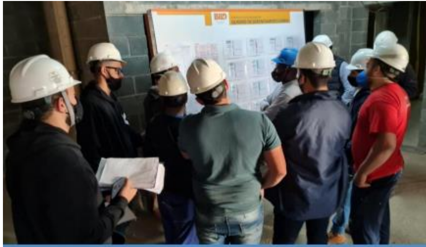
Figura 14 – Reunião de Check-in em Obra
