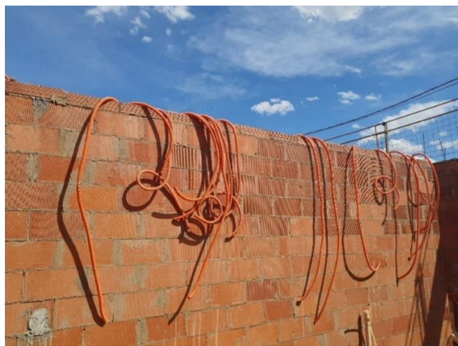
Figura 5 - Eletrodutos passando dentro dos vãos dos blocos, sem afetar a estrutura.
