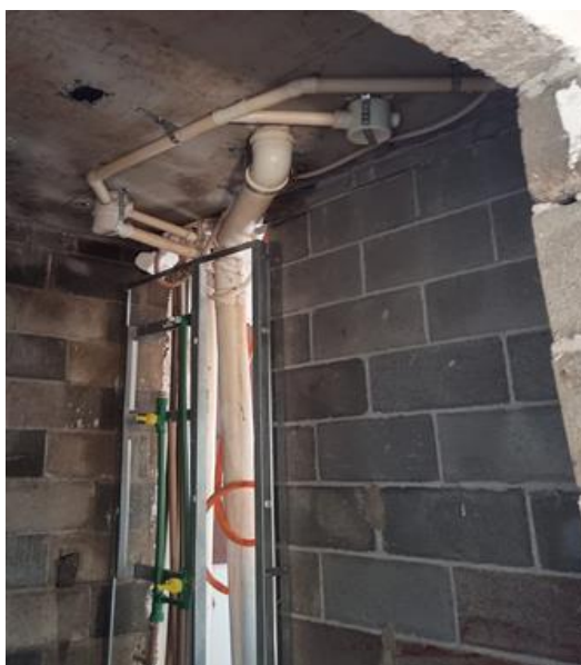
Figura 4 - Shaft hidráulico que foi compatibilizado com a alvenaria.
