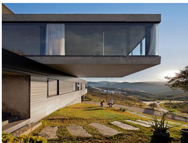
Figura 2 - Estrutura em concreto armado com grande vão em balanço.
