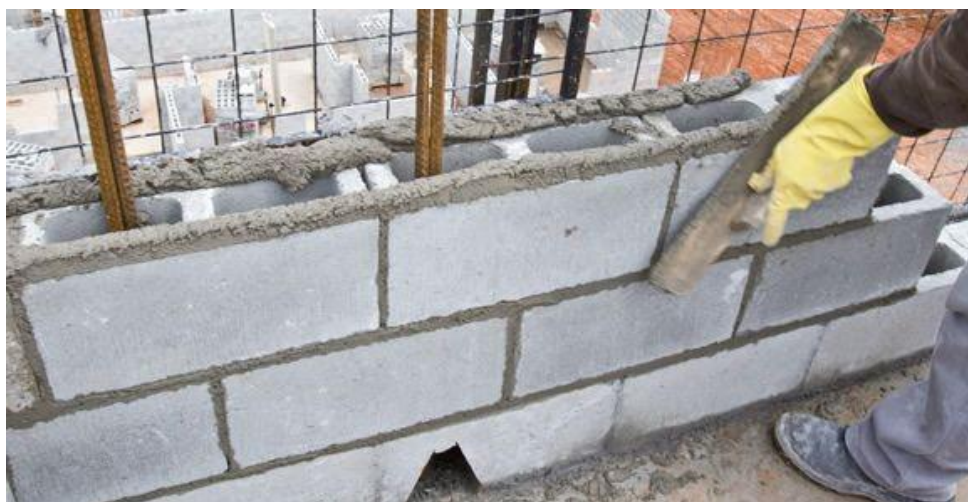
Figura 11 - Cordões de argamassa formados para o assentamento dos blocos.
