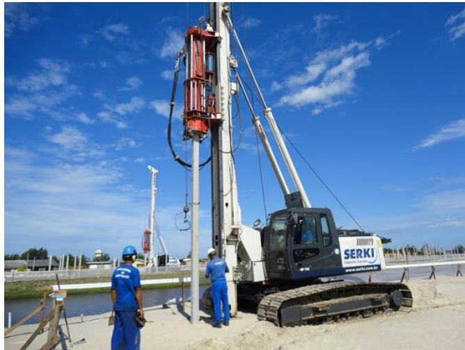
Figura 2 – Processo de cravação de estaca metálica.
