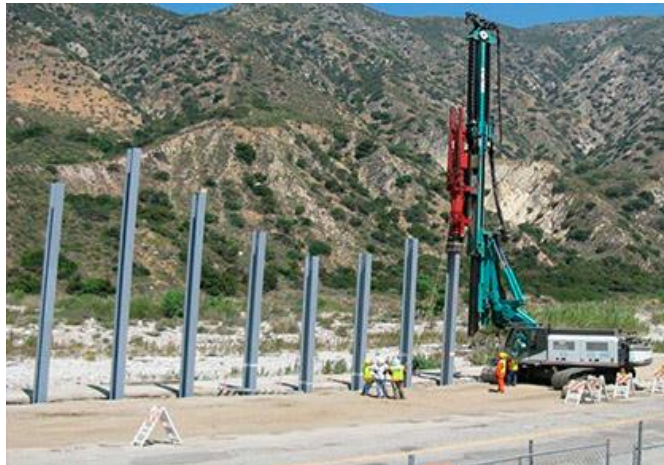
Figura 10 – Cravação de perfis metálicos.
