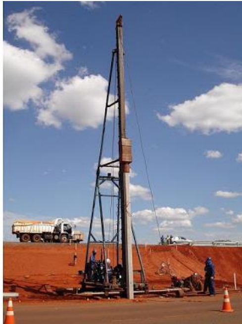
Figura 8 – Cravação de estaca pré-moldada de concreto.
