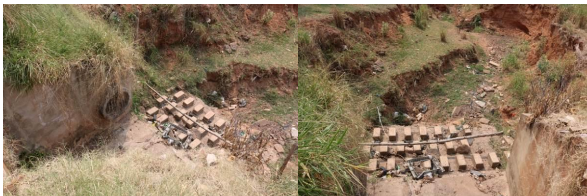
Figuras 46 e 47: Saída do Esgoto e estrutura de redução de velocidade da água na cidade de Presidente Prudente/SP.
