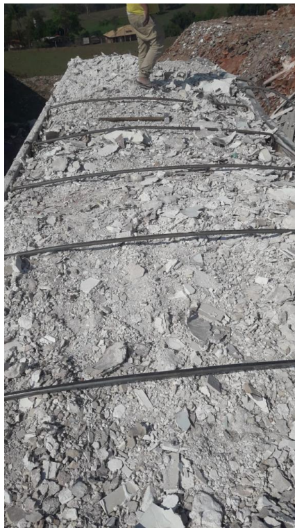
Figura 11- Resíduos da Construção Civil dispostos em caçamba
