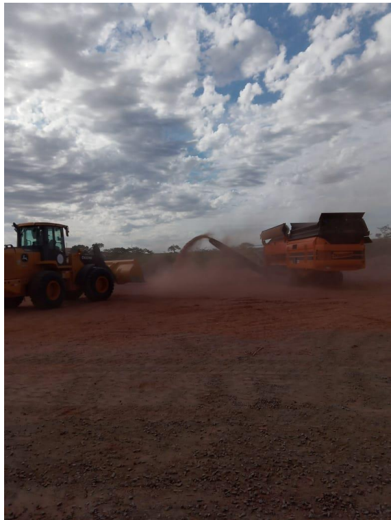
Figura 05- Resíduos sendo triturados na máquina
