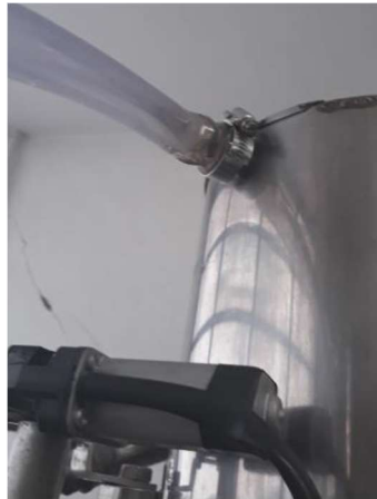
Figura 18 – Mangueira de escape do reservatório.
