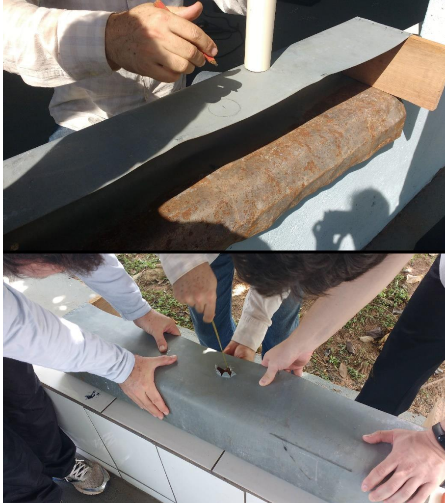
Figura 12 - Perfuração da chapa galvanizada para obtenção do extravasador da calha coletora.
