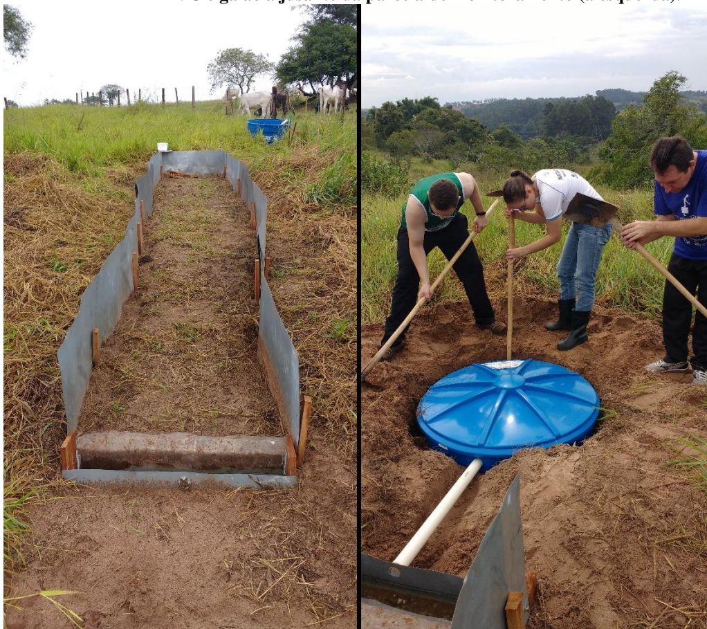
Figura 16 - Calha coletora instalada ao final da parcela de monitoramento (a direita) e fixação do tubo de PVC e galão a jusante da parcela de monitoramento (a esquerda).
