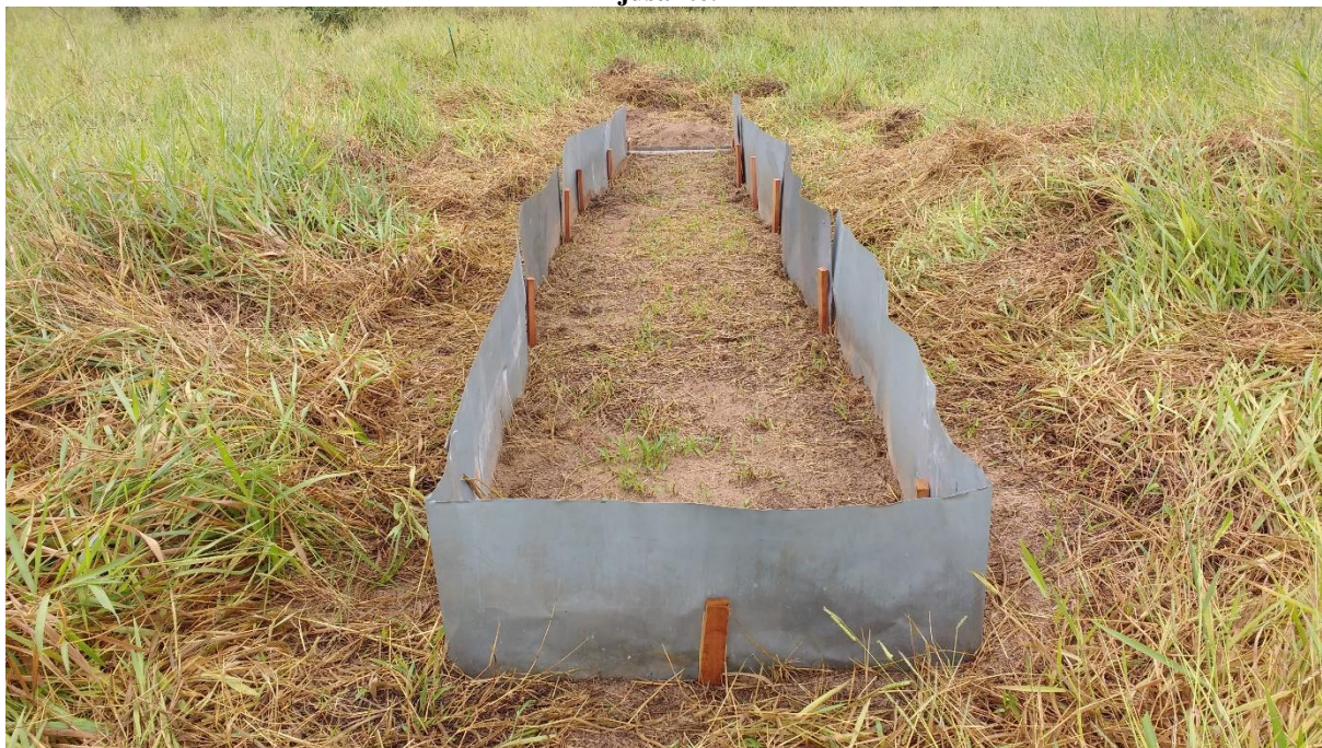
Figura 15 - Chapas galvanizadas instaladas na parcela de monitoramento, em visão de montante para jusante.
