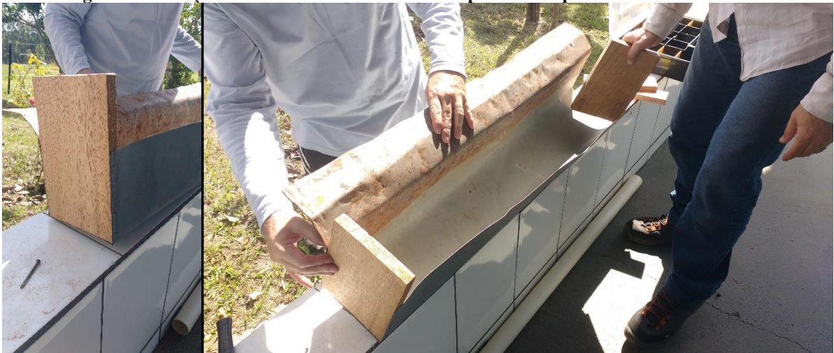
Figura 11 - Fixação de madeiras nas laterais da chapa dobrada para fechamento da calha.
