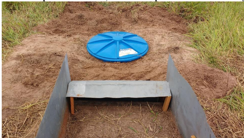
Figura 17 - Cobertura para calha coletora, de forma a impedir a entrada direta de água pluvial.
