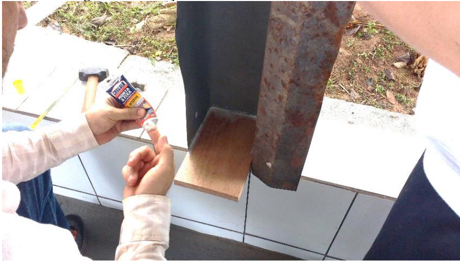
Figura 13 - Vedação da calha coletora com cola adesiva.
