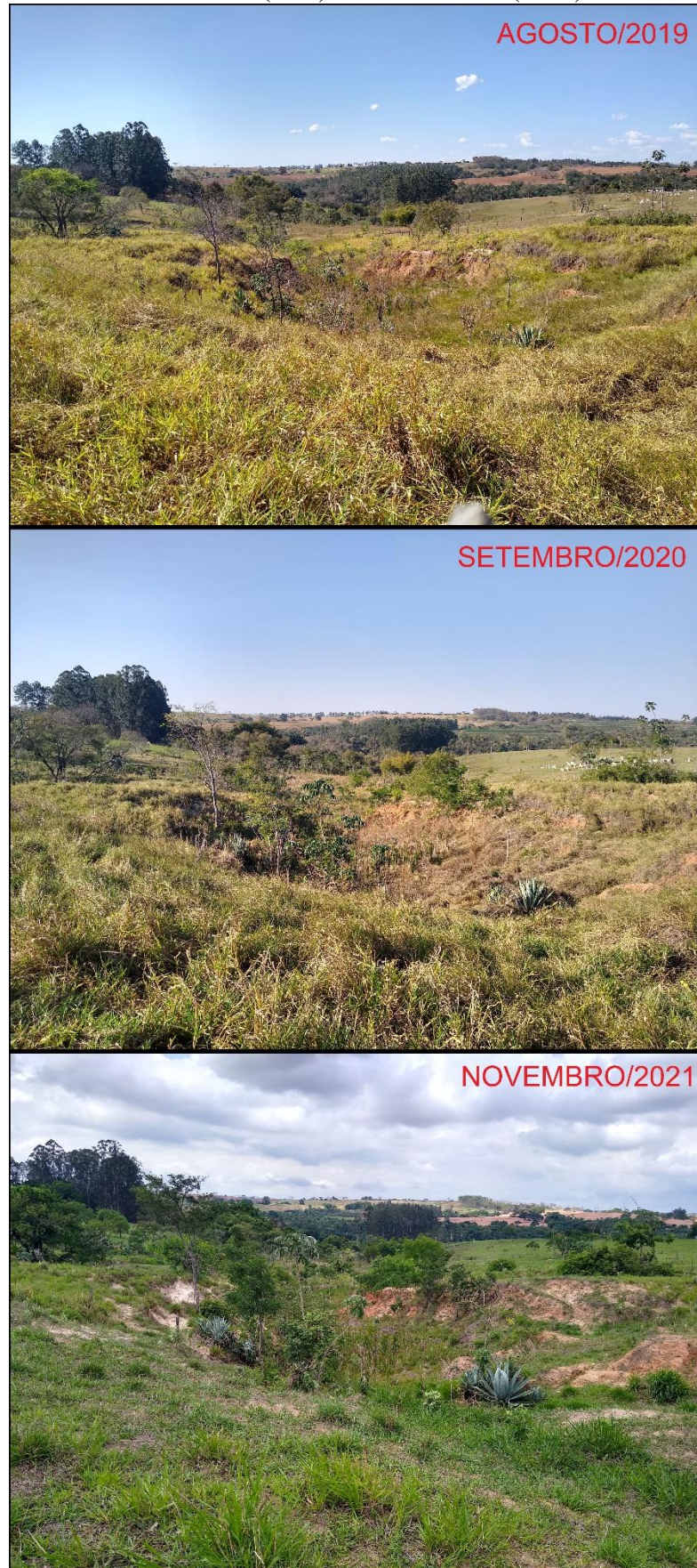
Figura 30 - Visão de montante para jusante da voçoroca existente na área em agosto/19 (cima), setembro/20 (meio) e novembro/2021 (baixo)
