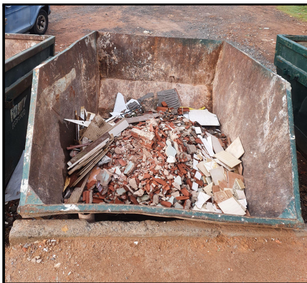
Figura 7 - Caçamba de 5m 3 para recebimento de RCD
