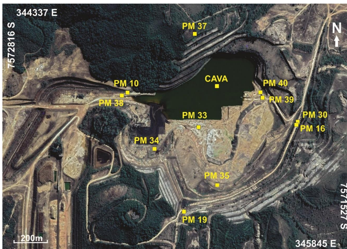
Figura 29: Localização dos poços de monitoramento.
