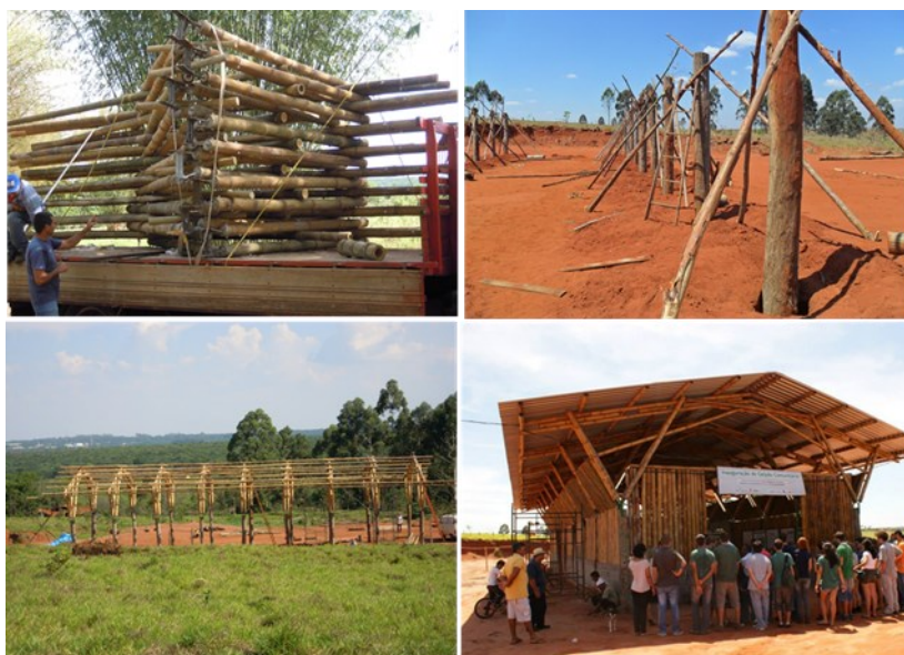
Figura 80 - Construção e inauguração do galpão/oficina Viverde
