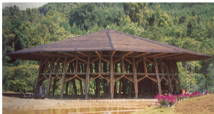
Figura 37 - Pavilhão Zeri, obra de Simon Vélez
