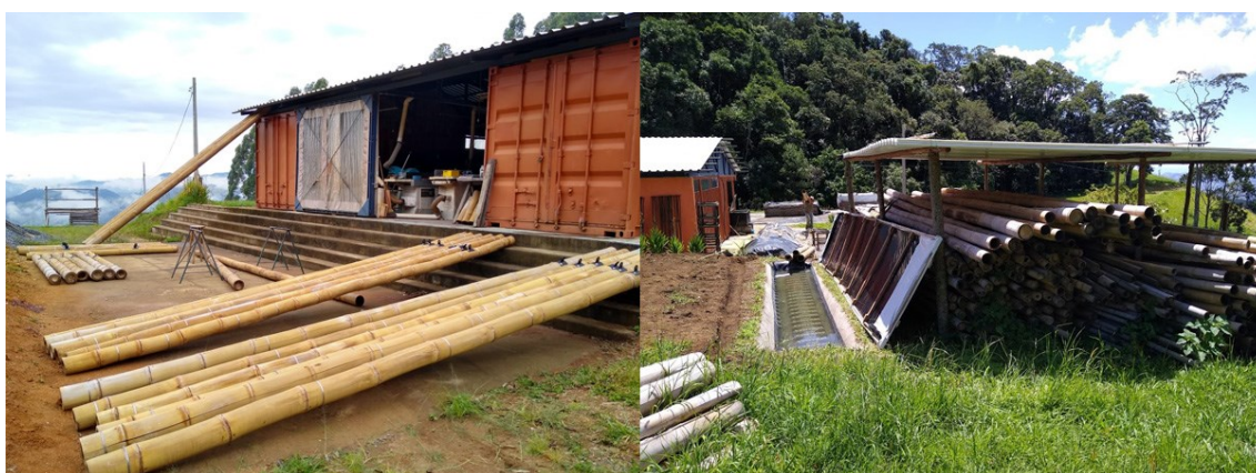
Figura 46 - Oficina, estocagem de colmos e tanque de tratamento
