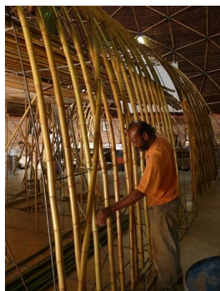
Figura 63 - Estrutura curva de bambu instalada no Mercado Central de Belo Horizonte/MG
