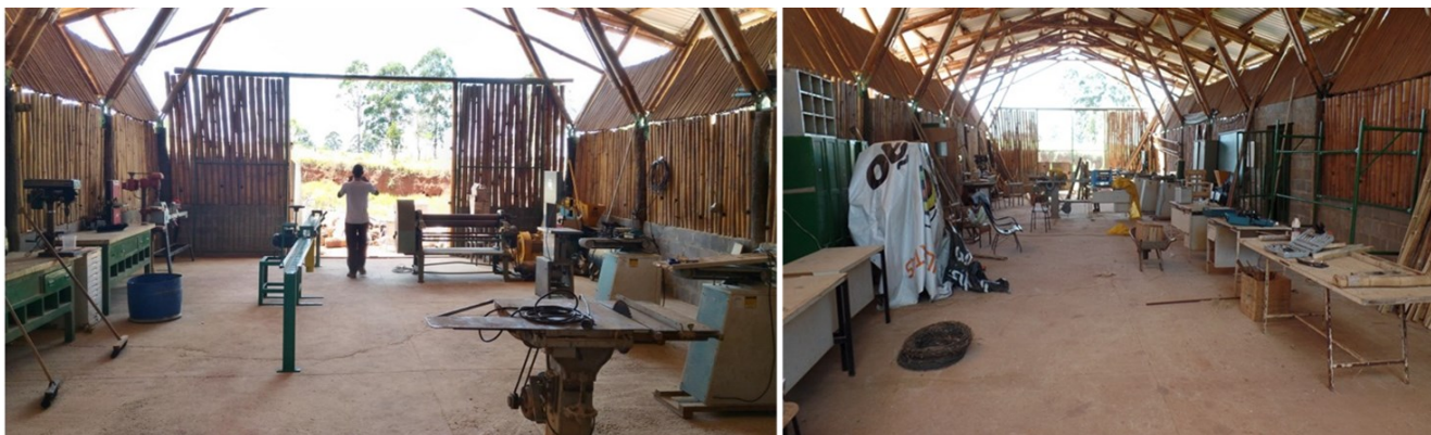
Figura 81 - Instalações no galpão/oficina Viverde
