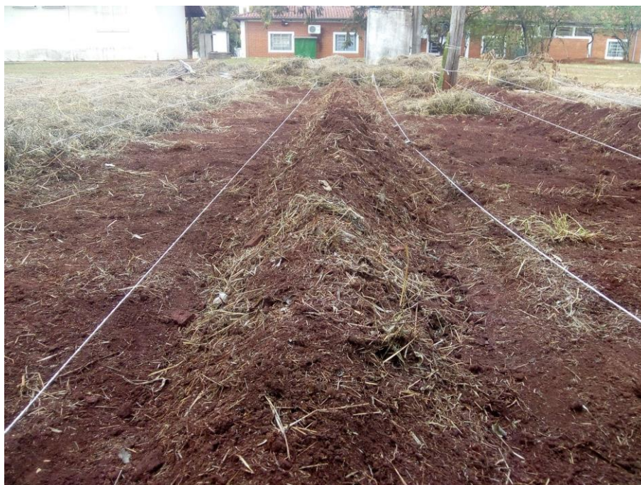
Figura 14 - Início da construção do canteiro no Módulo 2
