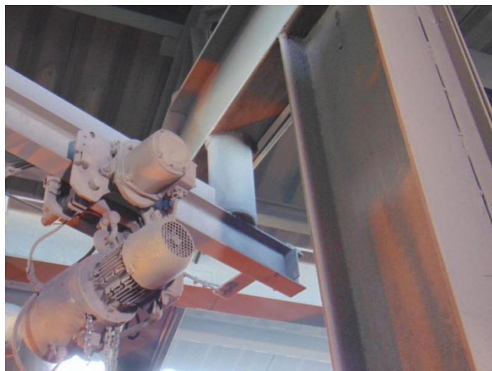
Figura 11 - Estrutura da monovia - Talha elétrica.
