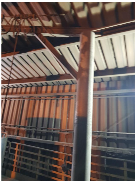
Figura 9 - Estrutura da monovia - Coluna de apoio presa ao chão e perfil I entre coluna e monovia.
