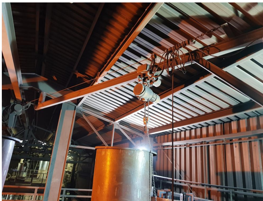
Figura 8 - Estrutura da monovia para carregamento de minério.
