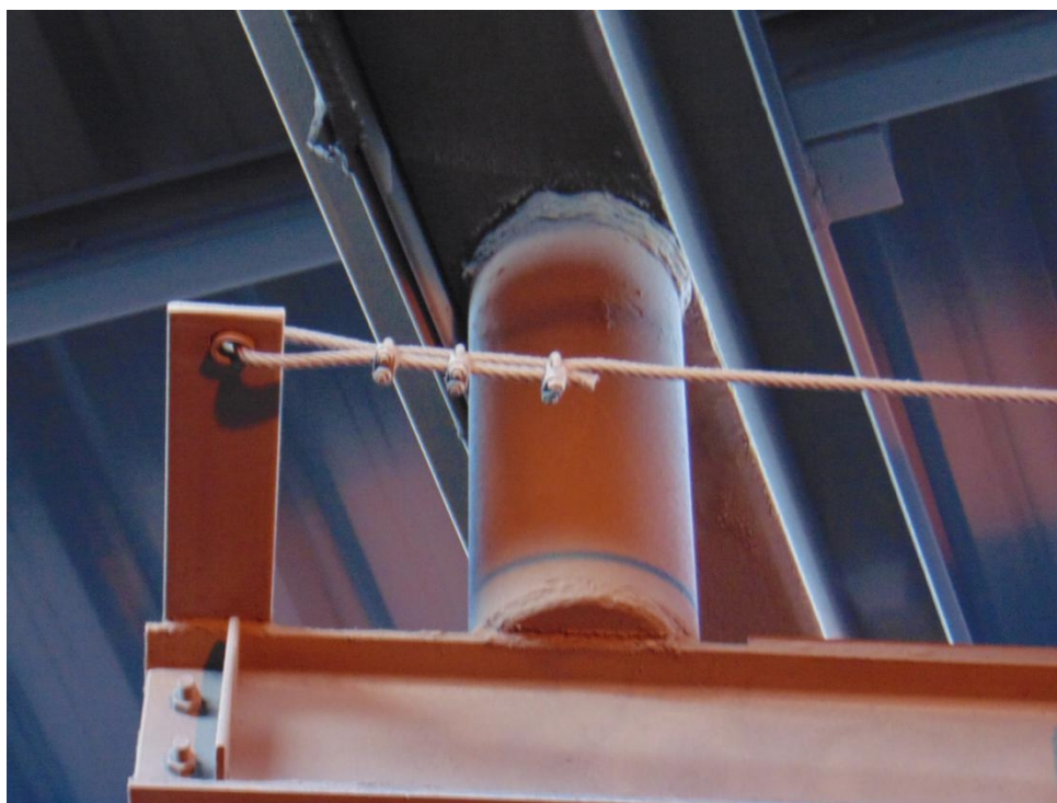
Figura 10 - Estrutura da monovia - Coluna tubular presa ao teto.
