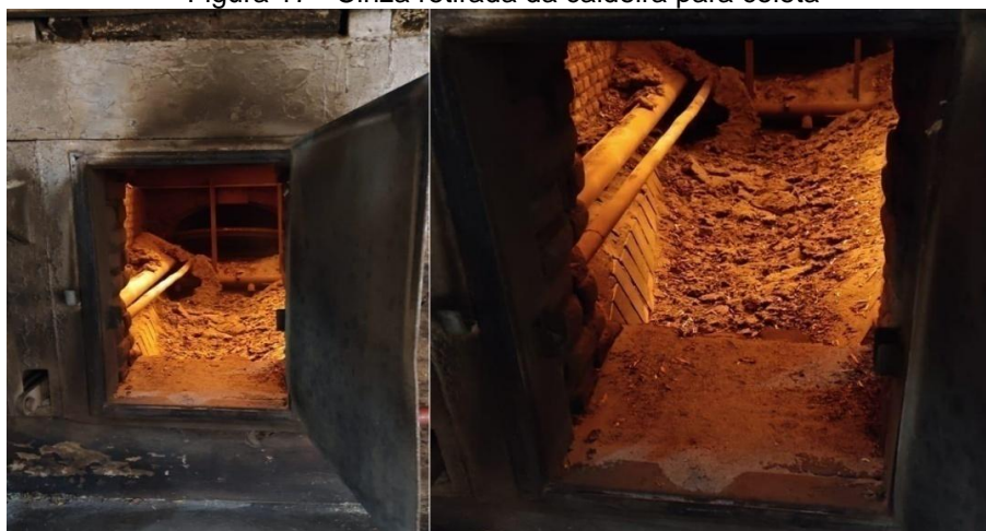
Figura 17 - Cinza retirada da caldeira para coleta
