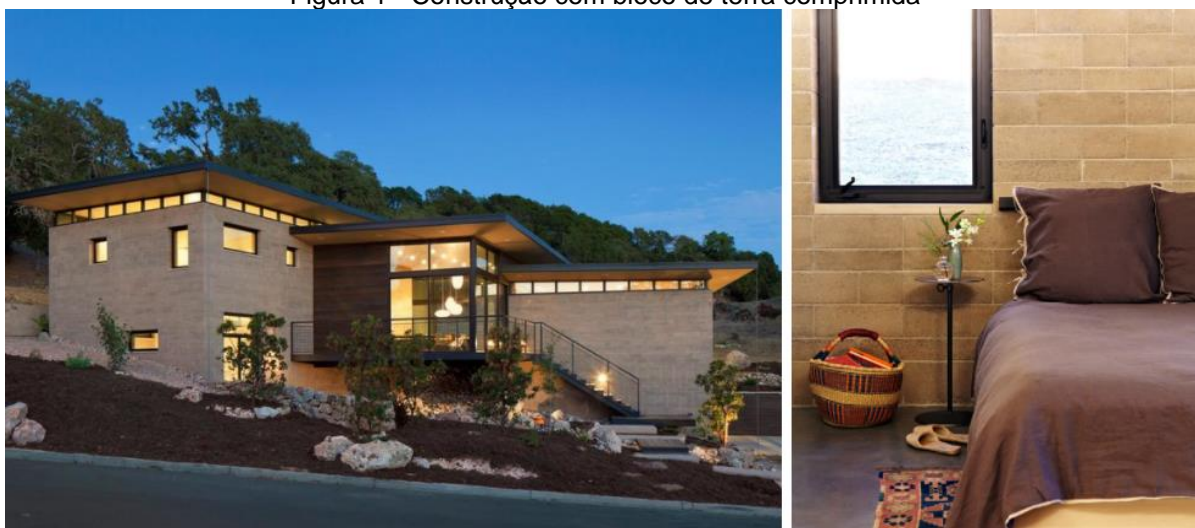
Figura 1 - Construção com bloco de terra comprimida
