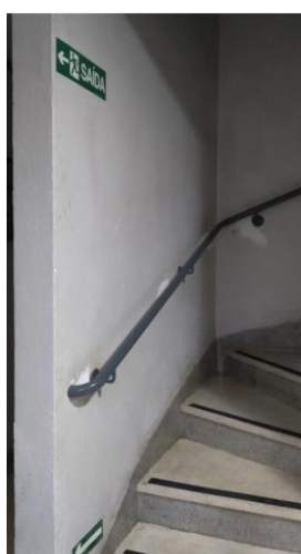
Figura 93 – Corrimão tubular novo
