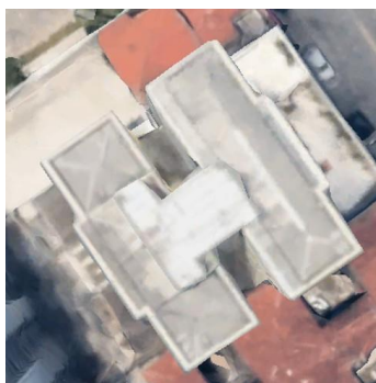
Figura 96 – Imagem aérea do telhado do Edifício Casemiro de Abreu
