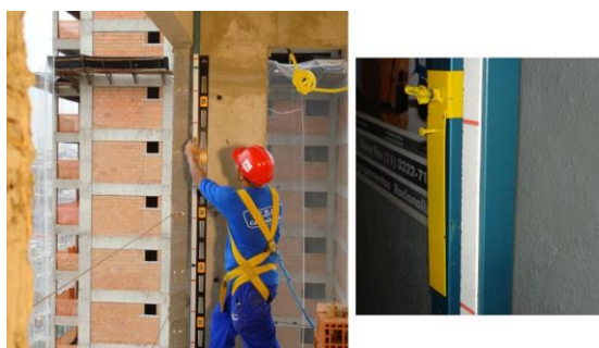
Figura 28 – Escantilhão com regulagem telescópica
