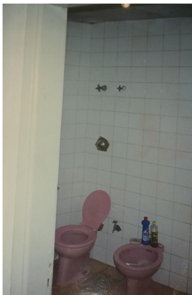
Figura 71 – Fotografia do banheiro tirada em 1996
