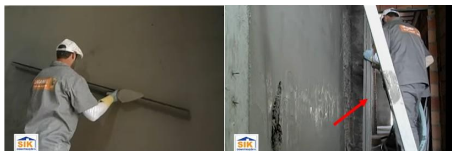
Figura 43 – Uso da régua H em reboco projetado
