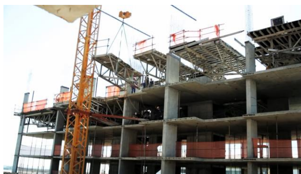
Figura 19 – Mesa voadora sendo posicionada por grua
