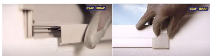
Figura 59 – Colocação das guarnições/alizares
