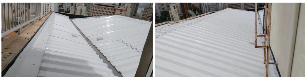
Figura 97 – Detalhe do caimento do telhado da região: (a) esquerda; (b) direita
