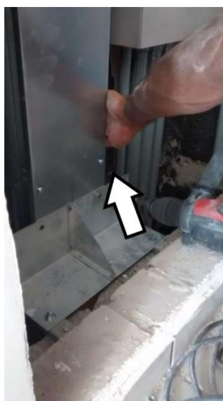
Figura 82 – Barramento blindado sendo perfurado para fixação
