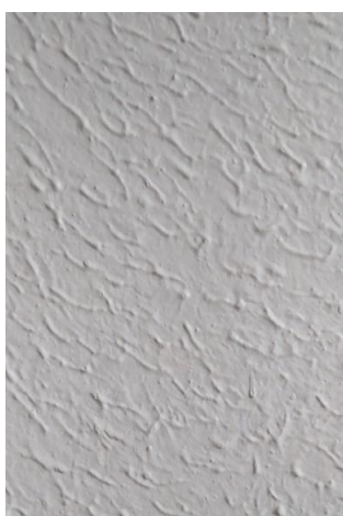
Figura 41 – Acabamento original nas paredes internas do Casemiro de Abreu
