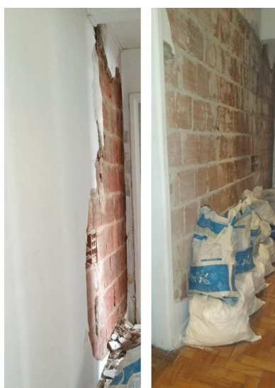
Figura 26 – Parede de alvenaria de vedação com tijolos cerâmicos
