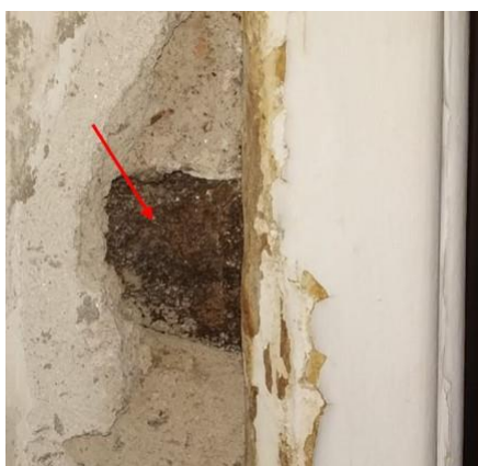
Figura 49 – Taco de madeira para fixação do batente da porta e guarnição branca
