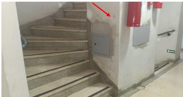
Figura 92 – Duto para passagem de lixo no Casemiro de Abreu
