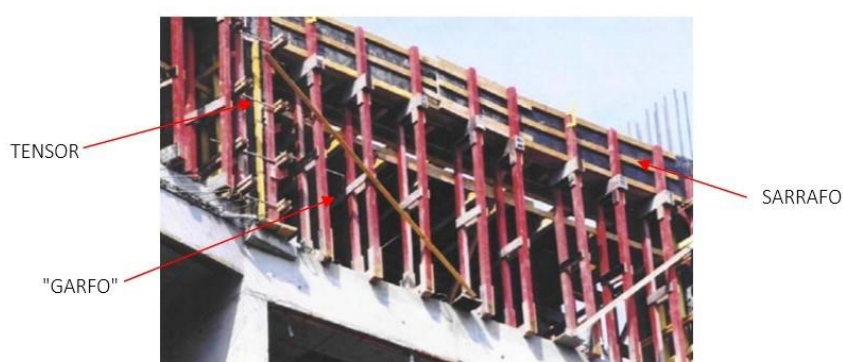
Figura 17 – Exemplo de fôrma do sistema Toshio Ueno em obra da construtora Cyrela
