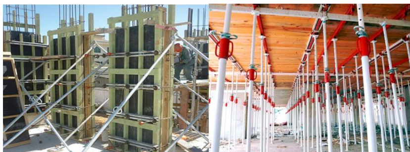
Figura 20 – Fôrmas de madeira e cimbramento metálico
