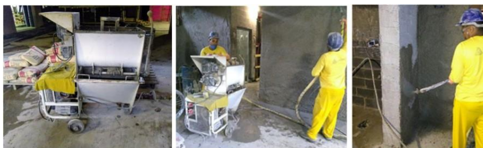
Figura 44 – Máquina de projeção e reboco sendo projetado
