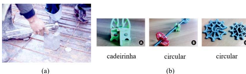
Figura 22 – Espaçador de: (a) concreto; (b) plástico
