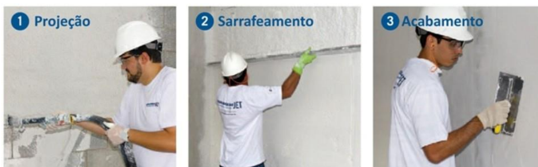
Figura 47 – Passo a passo da projeção mecânica de pasta de gesso
