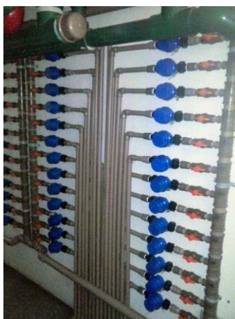
Figura 62 – Hidrômetros individualizados
