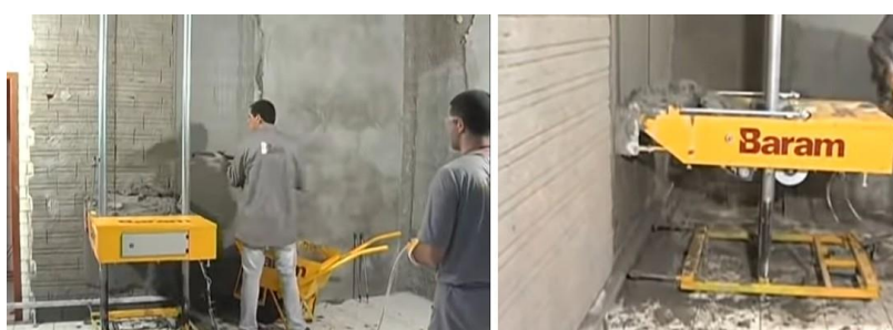
Figura 45 – Máquina rebocadora em funcionamento
