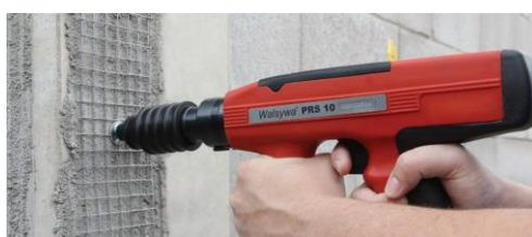
Figura 32 – Fixação de pinos à pólvora com finca pinos
