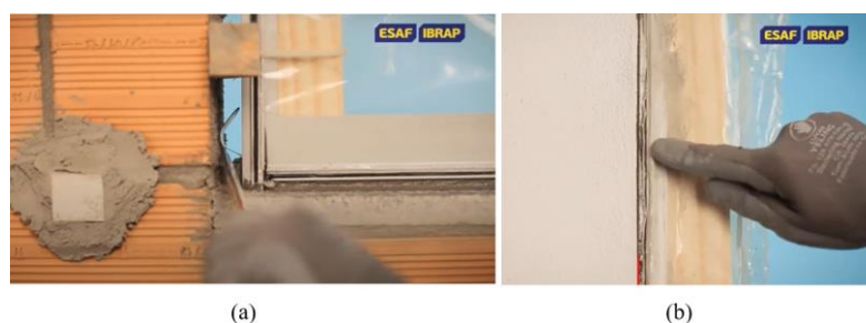
Figura 56 – Execução: (a) abertura grapa para chumbamento com argamassa; (b) acabamento
