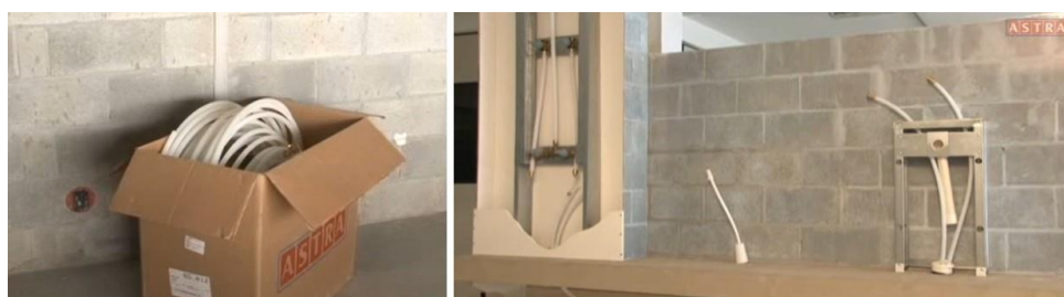
Figura 70 – Kit industrializado de tubulações PEX e chassi estrutural
