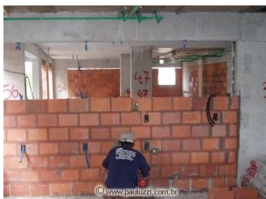
Figura 77 – Alvenaria racionalizada com pontos de elétrica pré-definidos
