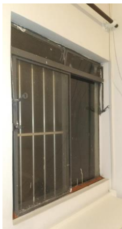
Figura 54 – Janela de ferro da sala de estar
