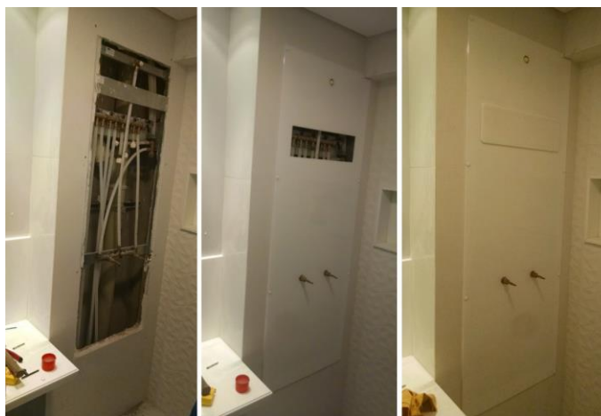
Figura 66 – Shaft vertical com acesso fácil
