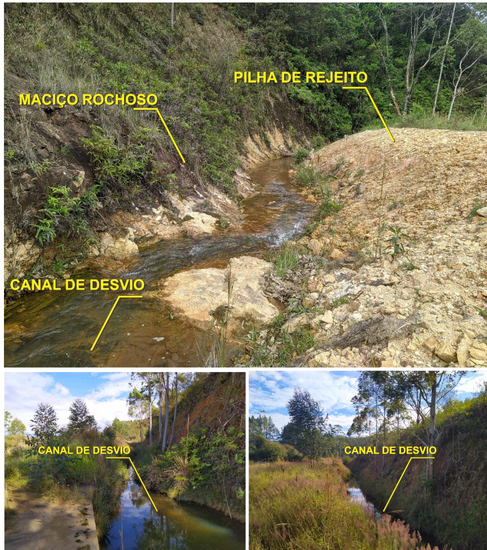
Figura 8 - O contato do canal de desvio com o BF-04 e o maciço rochoso (limite norte na pilha de rejeito).
