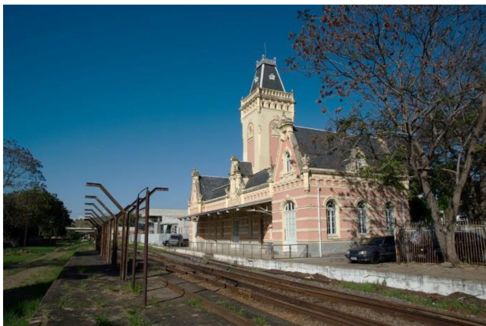
Figura 33 – Estação da Estrada de Ferro Central do Brasil restaurada, 2018
