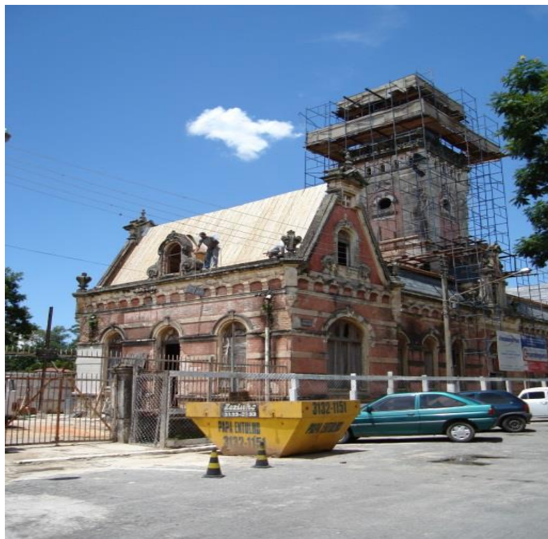
Figura 32 – Estação da Estrada de Ferro Central do Brasil durante a reforma em 2006
