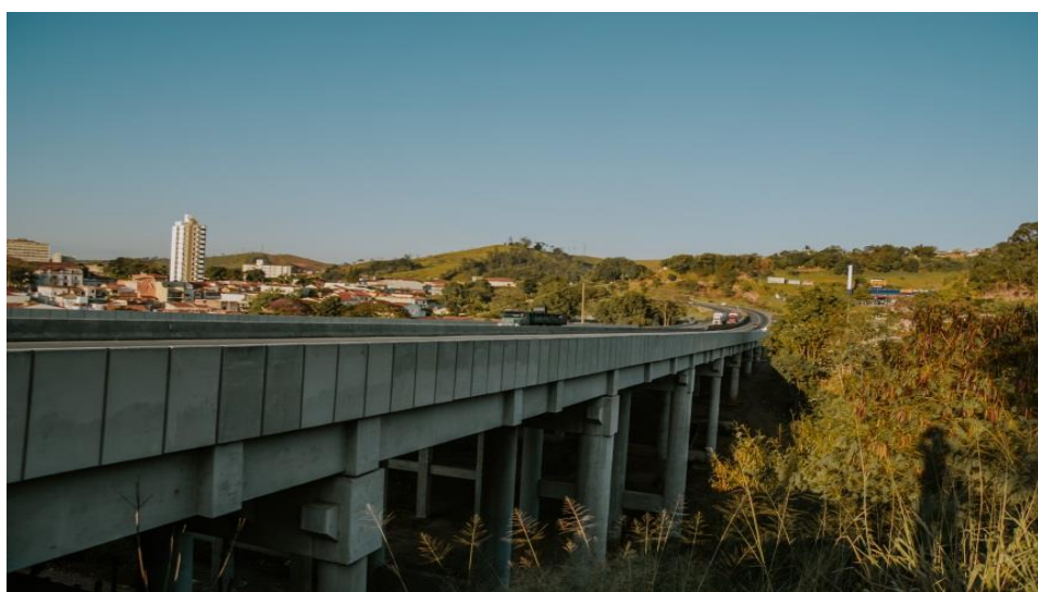
Figura 44 – Viaduto da Rodovia Presidente Dutra, sobre o Ribeirão São Gonçalo, Junho 2018
