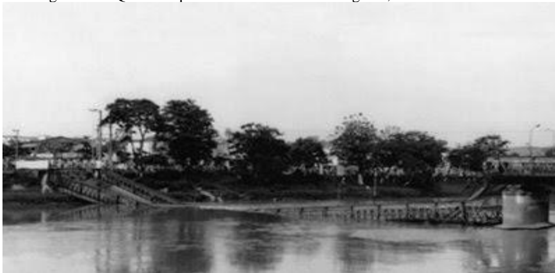
Figura 48 – Queda da ponte metálica de Guaratinguetá, em Outubro de 1987
