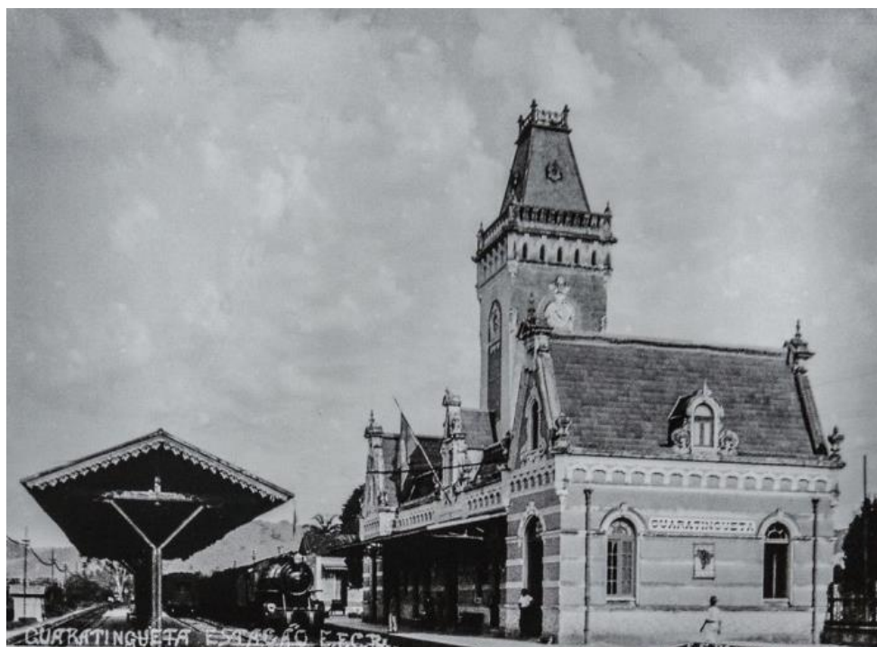
Figura 30 – Estação da Estrada de Ferro Central do Brasil, 1930
